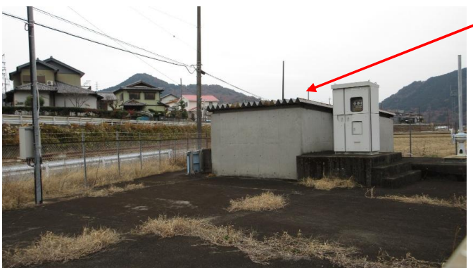
屋根 折板トタン
