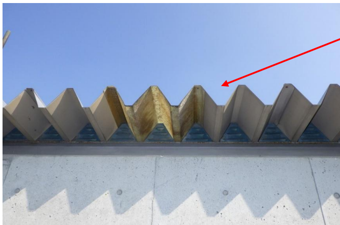
屋根 折板トタン
