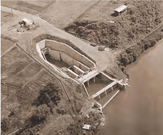
愛知用水の取り入れ口兼山取水口は、愛知用水の水源牧尾ダムから木曾川を120km下った岐阜県加茂郡八百津町（河口から約78km）にあり、関西電力（株）の兼山ダムの直上流に位置し、3門のゲートにより最大毎秒30m<sup>3</sup>を取水している。
