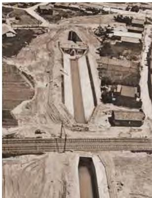
名鉄瀬戸線を掘り抜け、矢田川を横断するサイホンの入口に位置する開水路で、三郷水位調節堰が設けられている。
