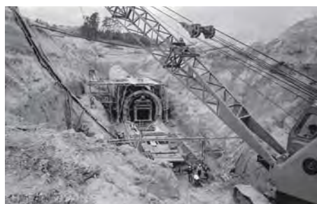
建設中の幹線水路
