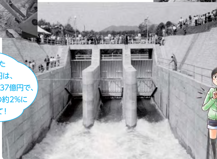
通水開始(兼山取水口)
