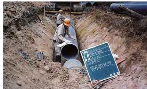
改修後の支線水路(管水路)
