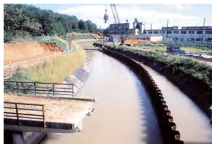
工事中の幹線水路
