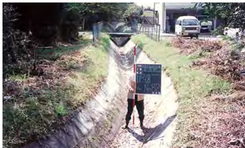
改修前の支線水路(開水路)
