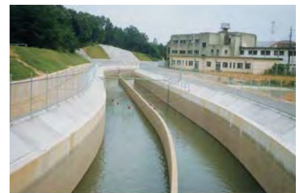
改修後の幹線水路
