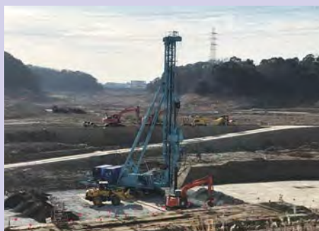
地盤を改良している様子
