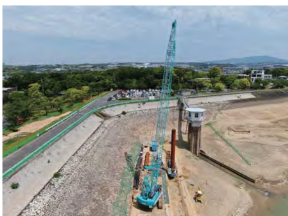
杭を打っている様子
