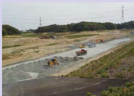
補強のための土を盛っている様子
