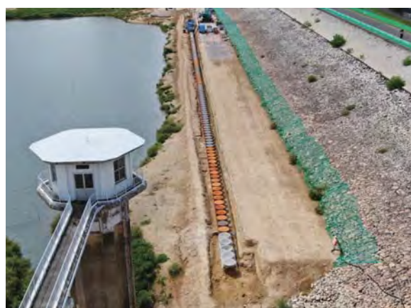
打った杭が並ぶ様子
