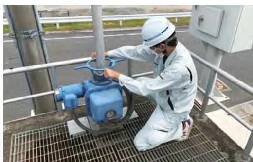
現地での送水の作業
