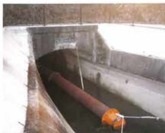
仮廻し管の設置
