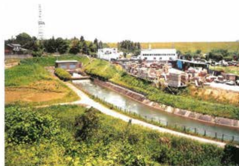
愛知池直下流の前川開水路は コンクリートブロック上張り 工法で改築した
