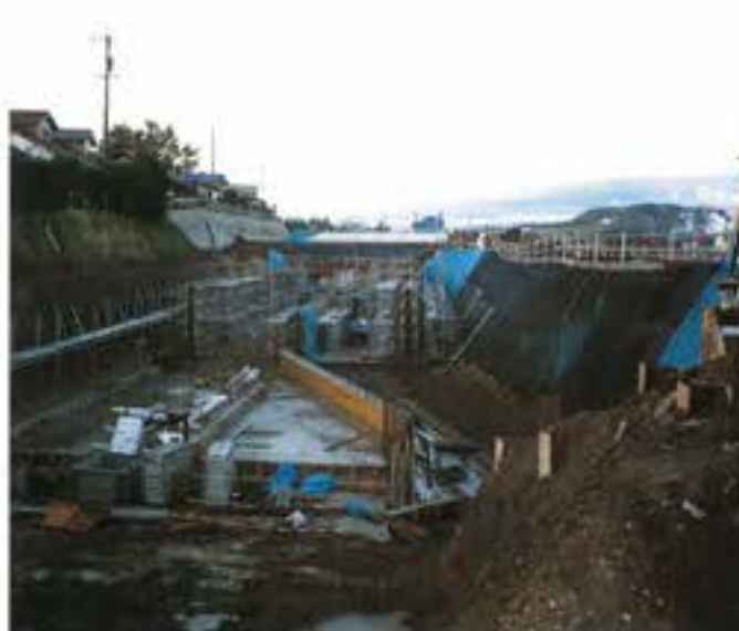
本体工事中（全断面施工）
