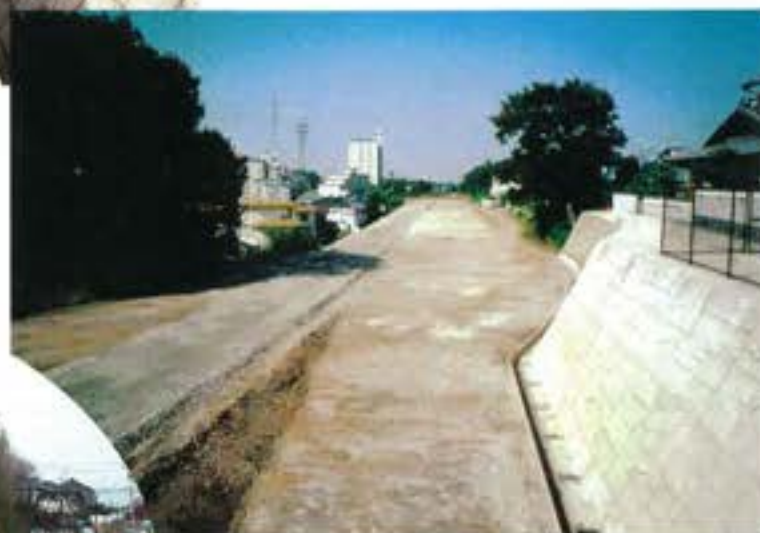
大将ヶ根暗渠完成
