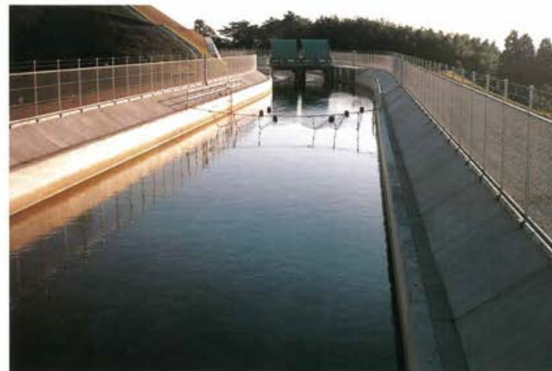
完成した城東開水路
