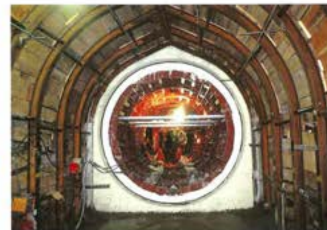
コンクリート打設
