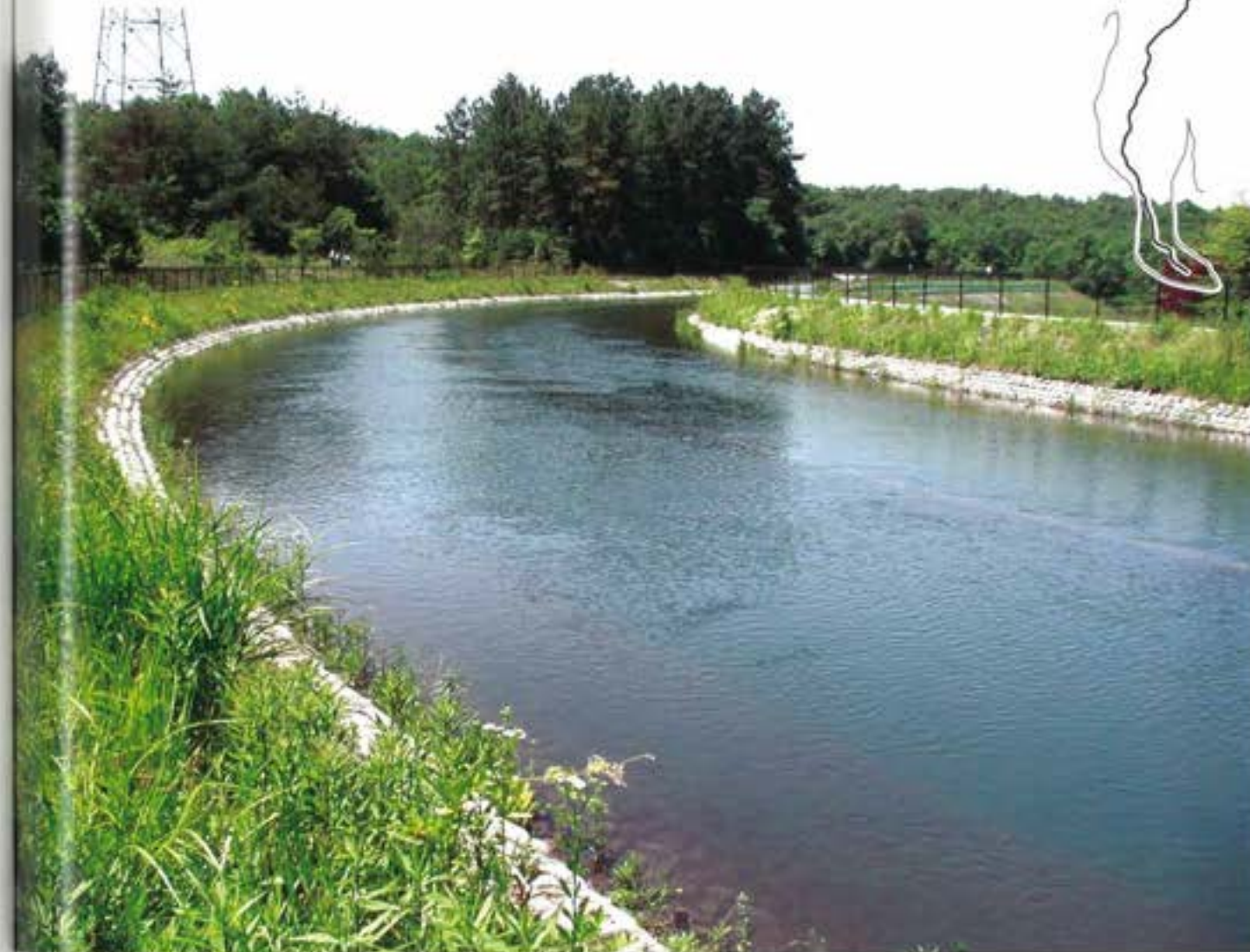
周辺環境にとけこんで流れる完成した水路
