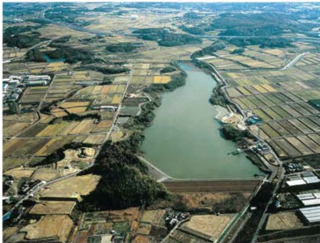
広大な農地の中に県営かんがい排水事業で新設され、愛知用水二期事業に承継された前山池、湖畔に下流管理の拠点として、下流管理所を新設した
