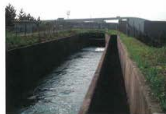
工事前のフルーム
