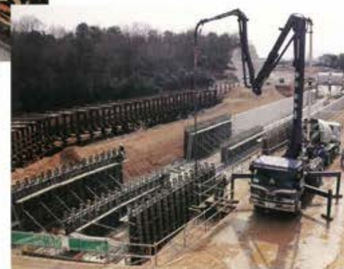
外廻し工法による全断面工事中
