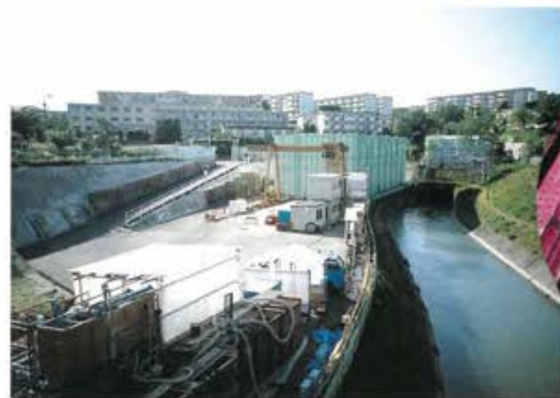
住宅地内の仮設（発進立坑・防音ハウス）
