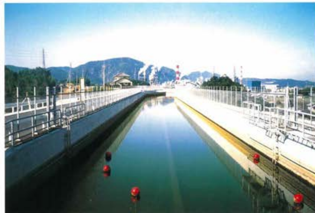
完成した徳野開水路
