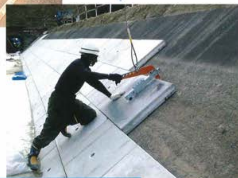
コンクリートブロック 上張り工事中
