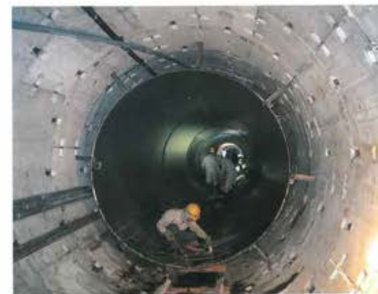
掘削完了後の鋼管布設工事中
