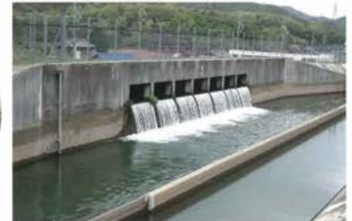
新規都市用水を犬山地点の木曾川から取水し、幹線水路城東開水路へ注水
