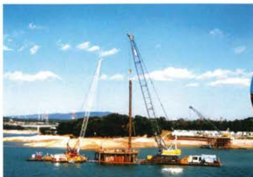
バイパス取水施設新設のための到達立坑仮締め切り工事中
