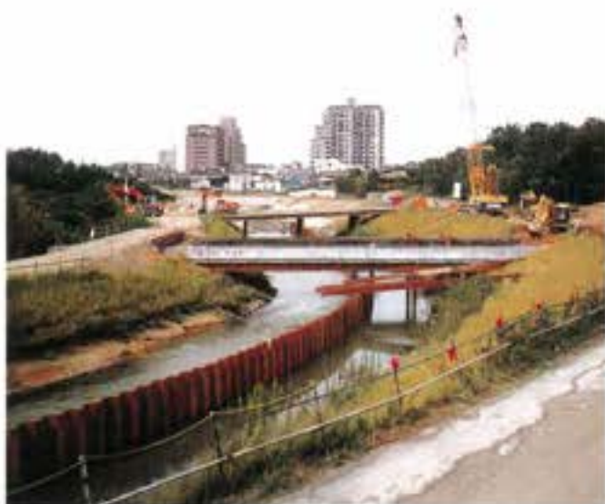
半川締切り用鋼矢板打込み作業中
