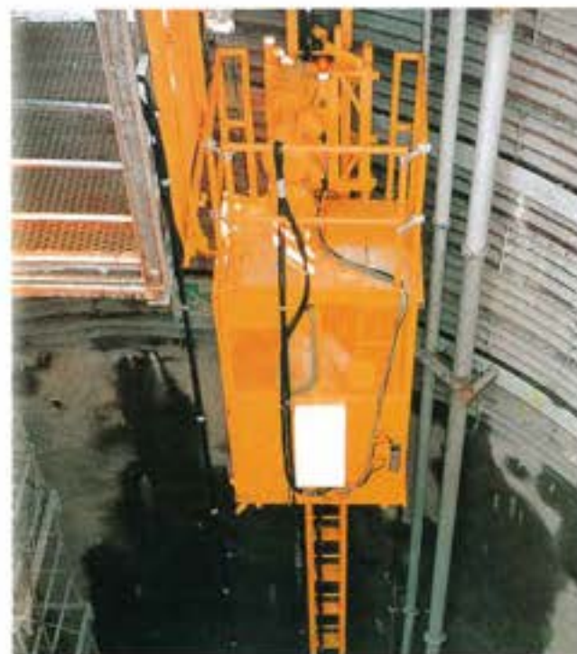
トンネル工事用立坑
