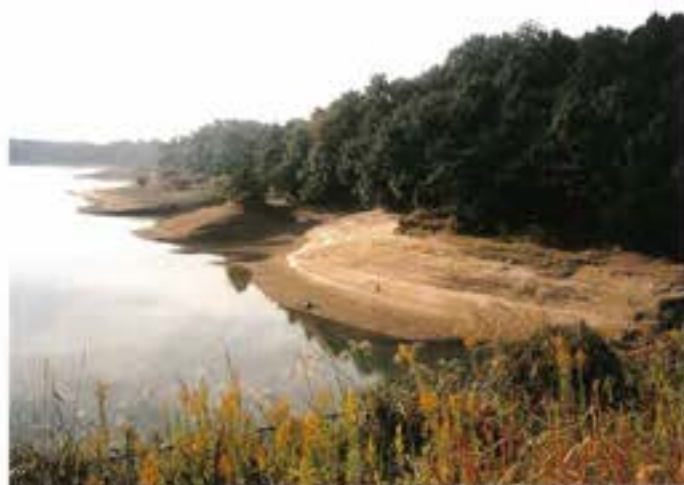
護岸工事前の法面崩壊が進んだ池周辺
