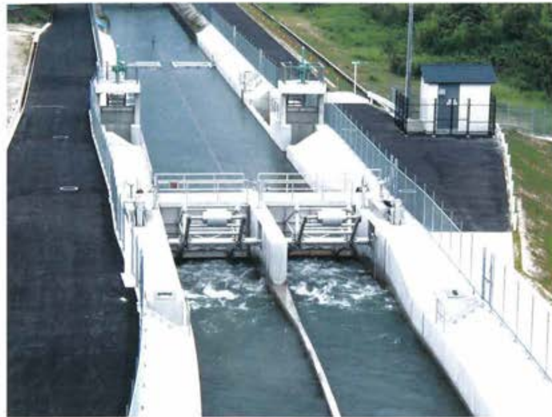
共用区間の水位調節堰（無動力自動ゲート）
