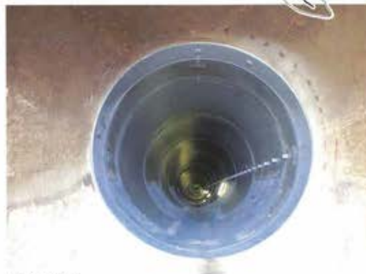
管体補強完成
