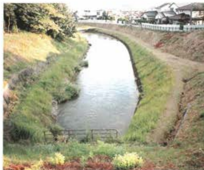
上流部工事前
