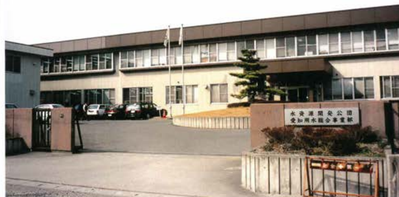
愛知県日進町（平成6年に日進市）
