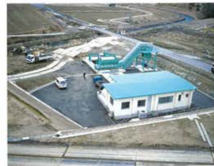
機場完成（後方は自動除塵機）
