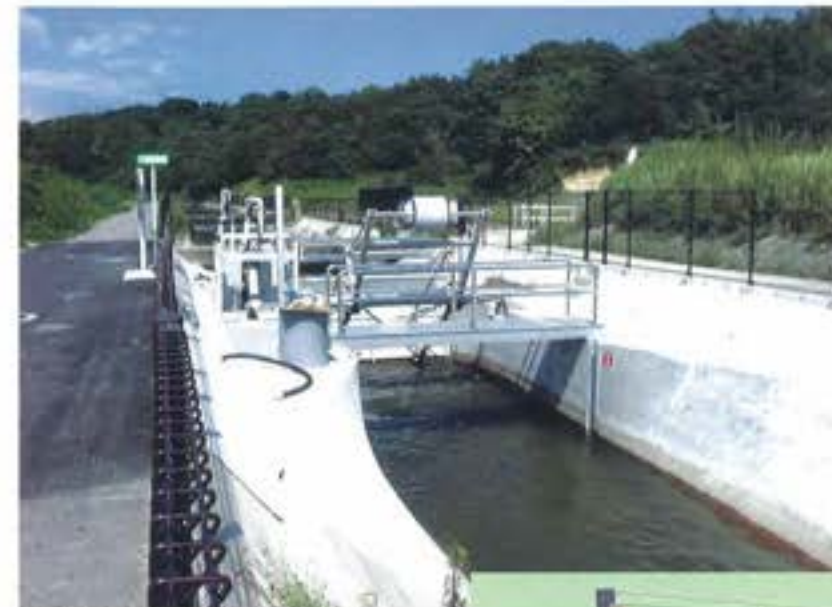
農業用水専用区間の水位調節堰（無動力自動ゲート）
