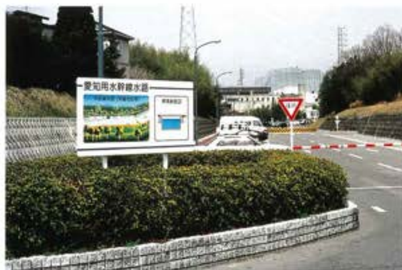
水路上部を駐車場として利活用
