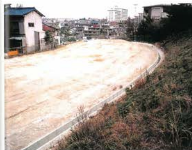
暗渠工事完成
