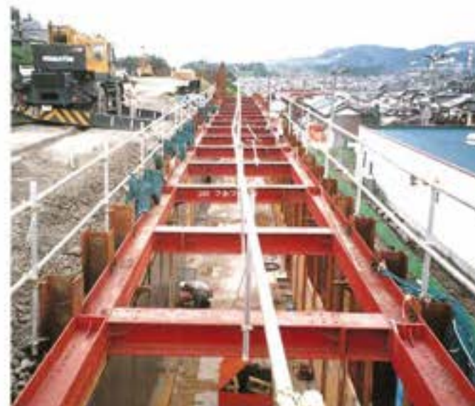
仮廻し（外廻し）水路工事中
