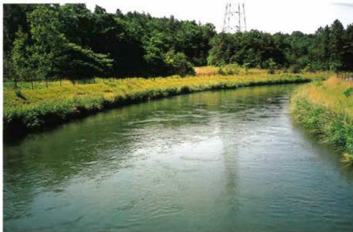
自然になじんで流れる工事前のアースライニング水路
