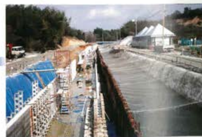
開水路本体一次工事
