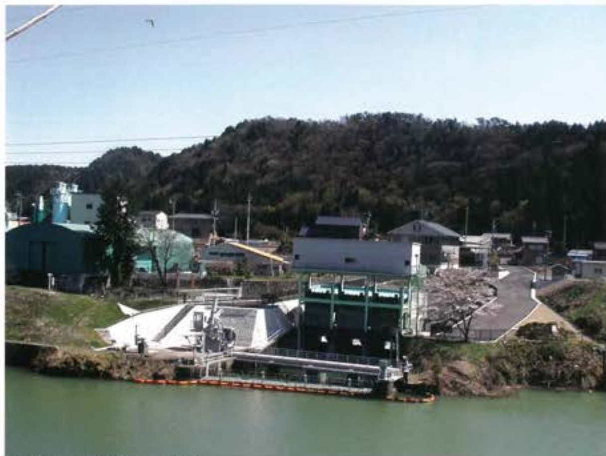
法面など周辺整備を施した兼山取水施設
