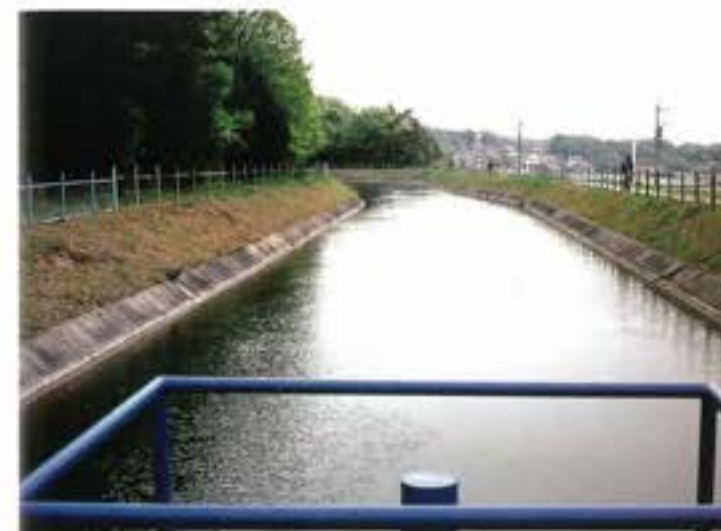
この開水路を二連化し自動除塵機を新設する
