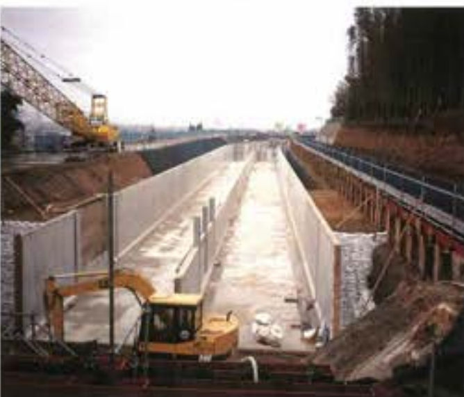
本体工事中（全断面施工）
