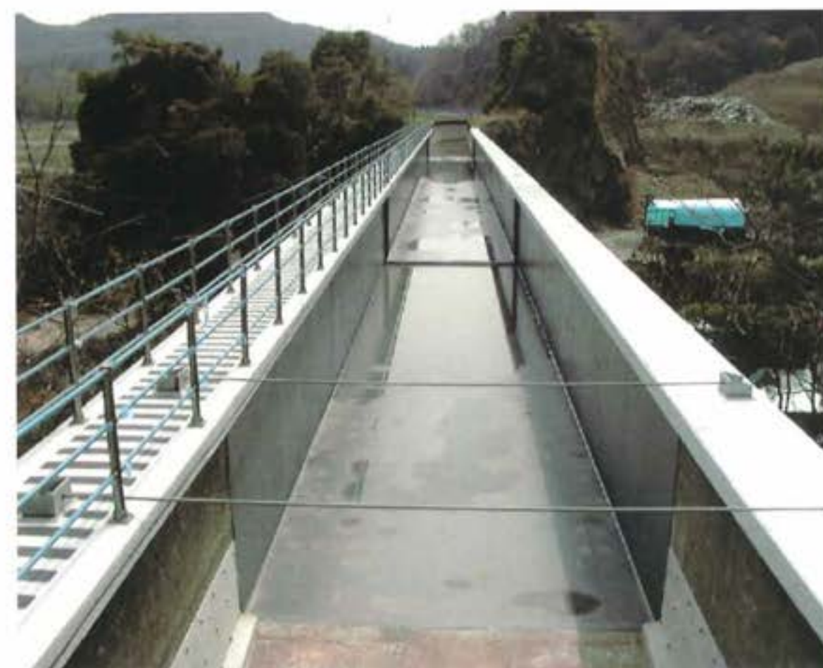
流水を富士バイパストンネルに切替え、工事を行った水路橋
