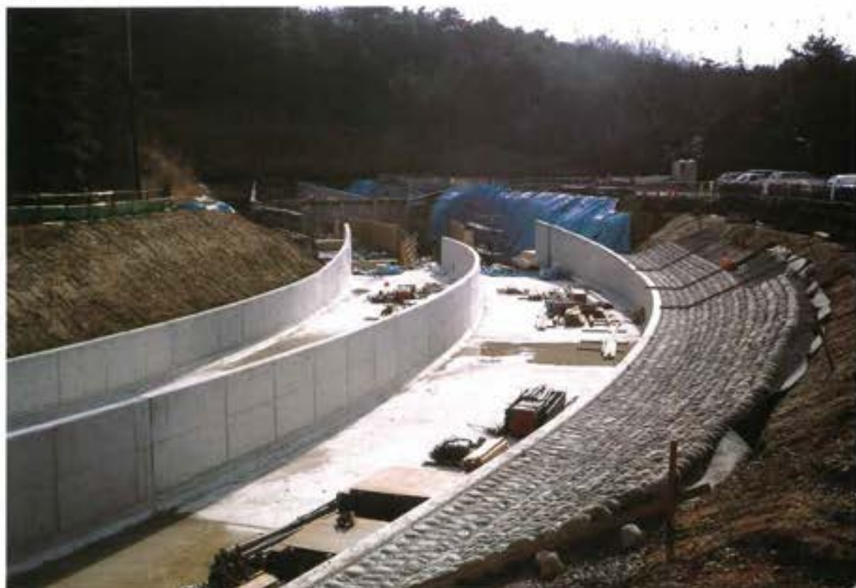
周辺環境に配慮した工法による二連水路工事中
