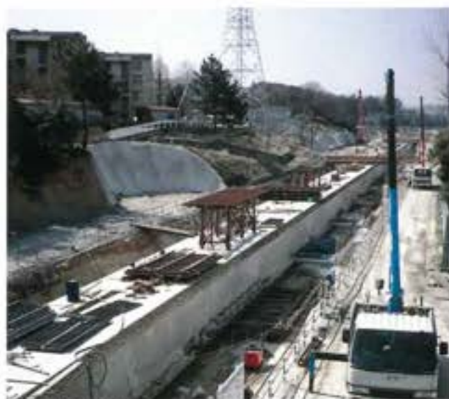
本体二次工事中
