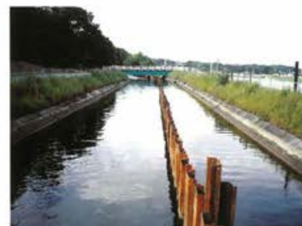
二連化のための半川締切り鋼矢板打込み
