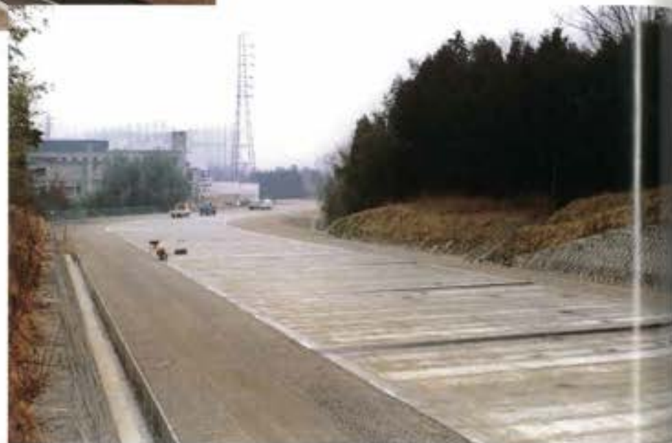
有蓋化を完成した水路上部
