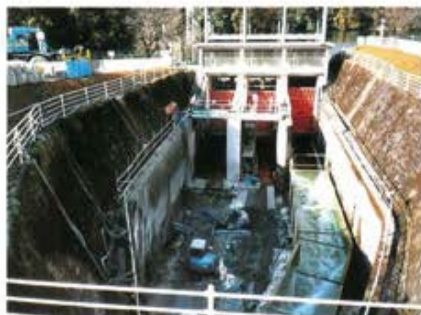
分流工施工時の仮遊し
