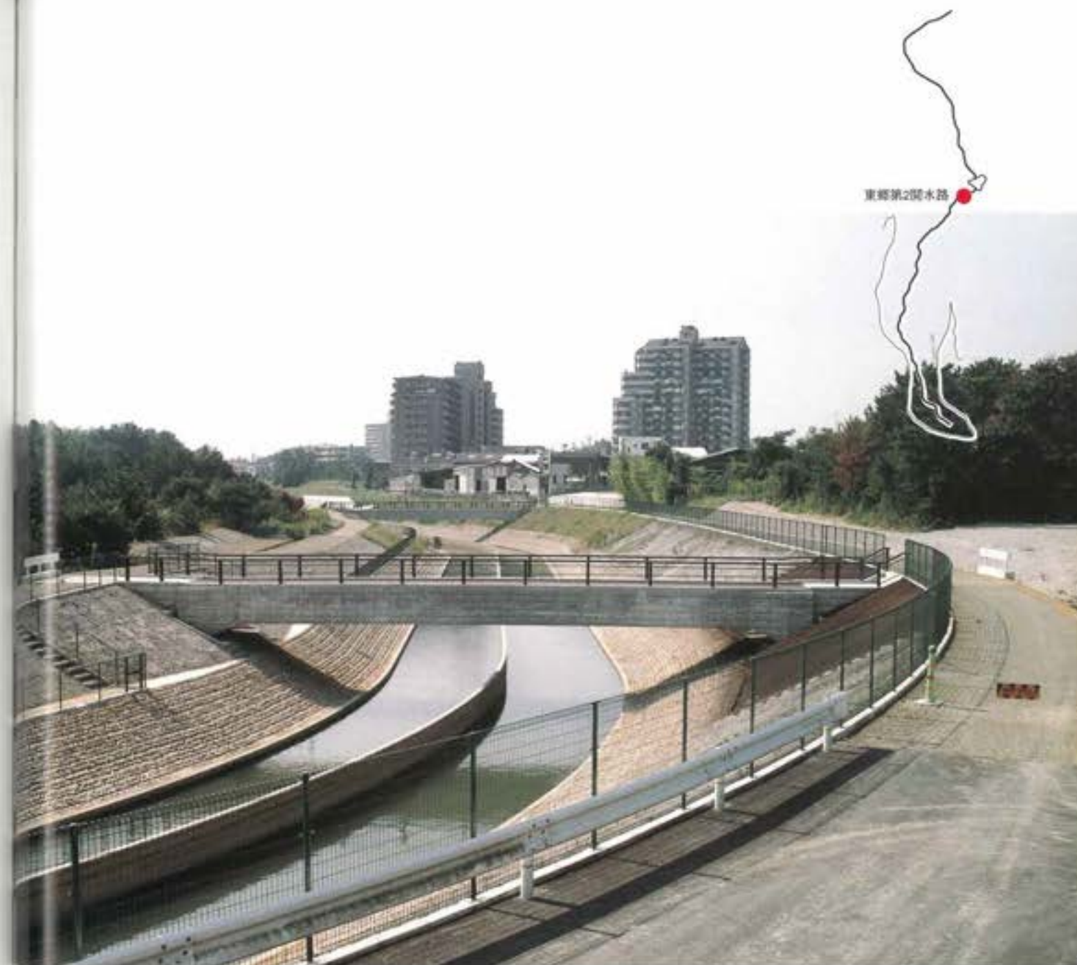
完成した東郷第2開水路
