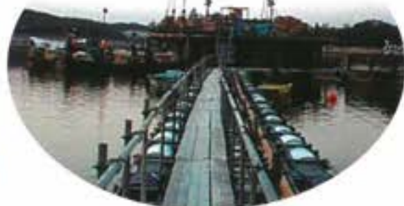
波り(浮き)栈橋
