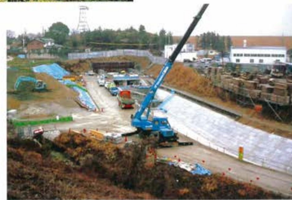
コンクリートブロック上張り工事中
