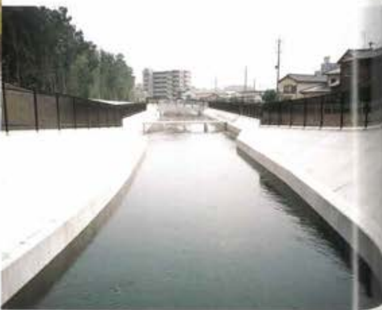
下流部は標準的な二連水路として完成
