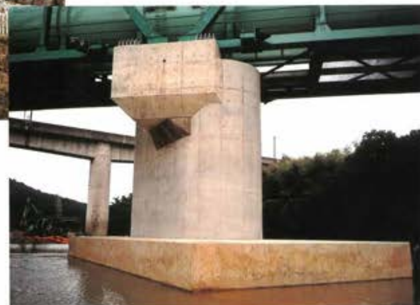
橋脚補強完成
