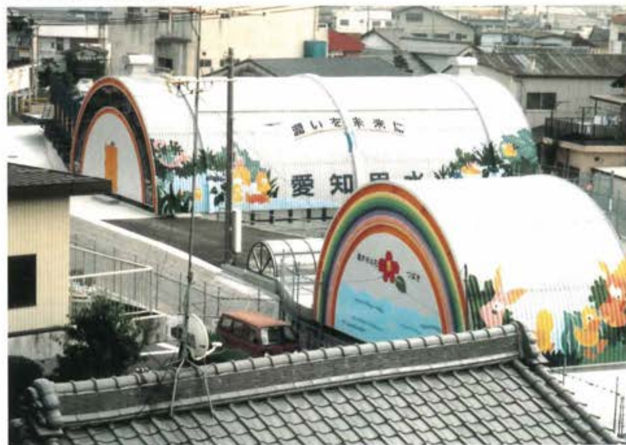
水位調節堰から流下する水音の騒音対策を兼ねたゲート室を設けた
