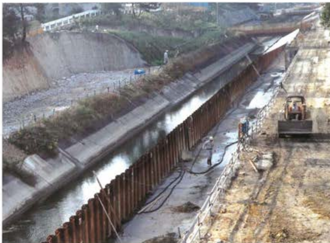
仮返し水路工事中
