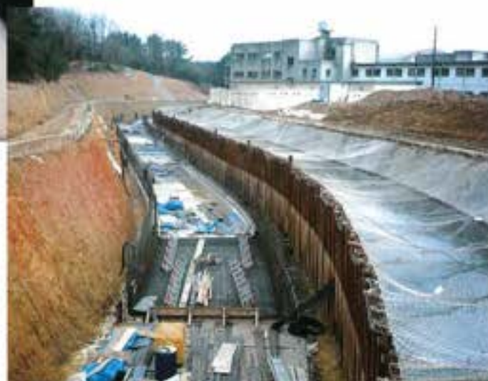
平川通水により本体片側工事中
