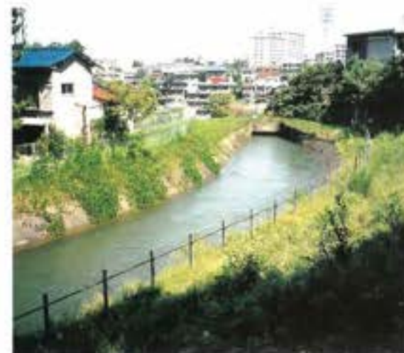
工事前の有松開水路
