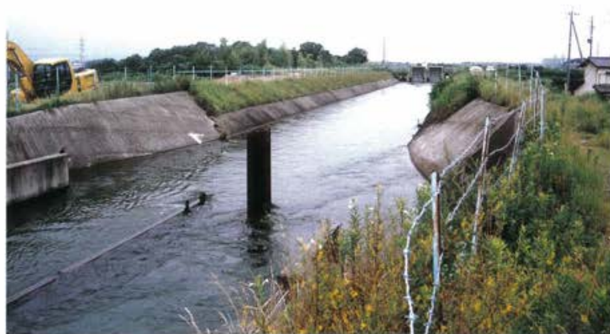
工事前の吉川開水路
