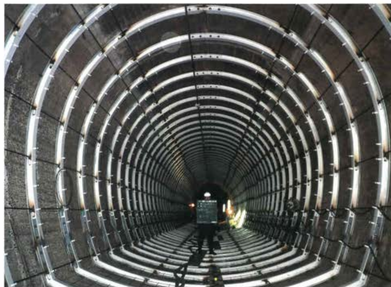
鋼製支保工立込完了
