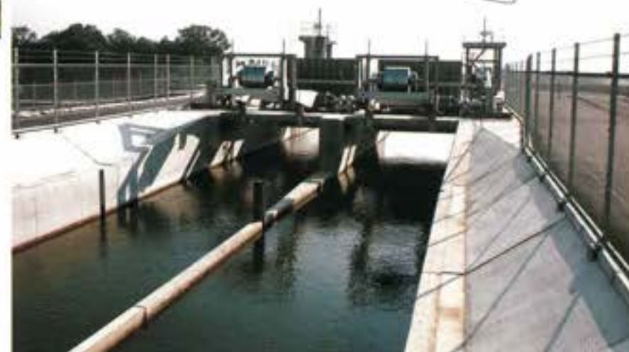
完成した吉川水位調節堰
