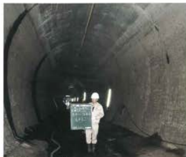
既設ライニング面清掃
