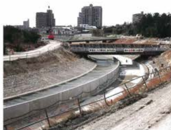
半川通水により本体片側工事中
