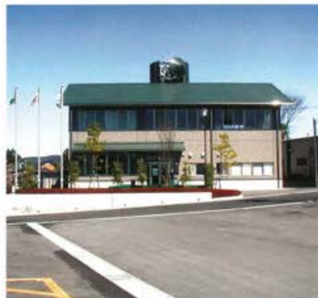
兼山取水口に新築された上流管理所
