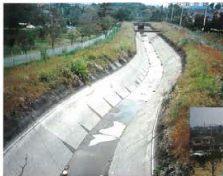
従前の開水路を清掃し、 コンクリートブロックを張る前の姿
