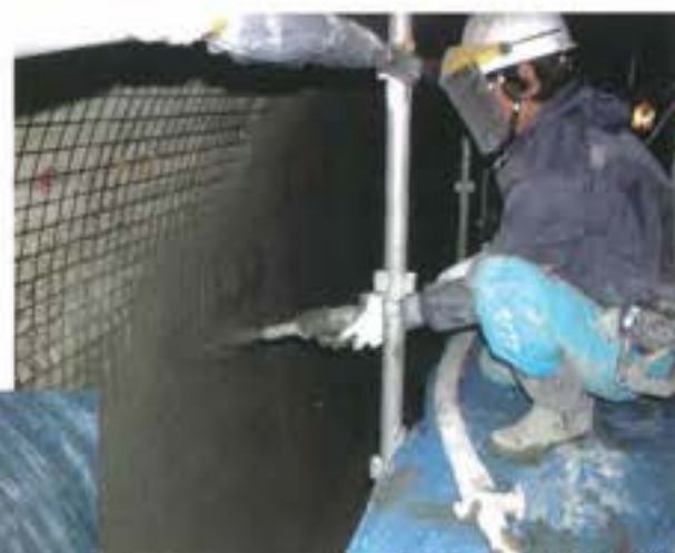
ポリマーセメント吹付け
