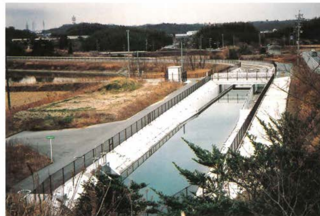
完成した北池第2開水路と北池放水工
