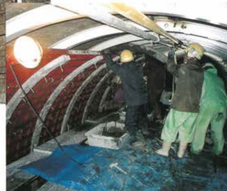
コンクリート打設
