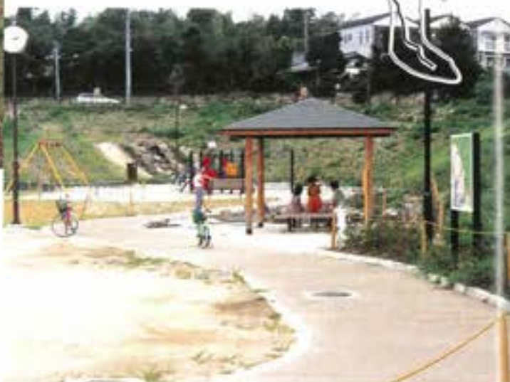
上流部は高切土部を暗渠化し上部を観水公園として利活用した
