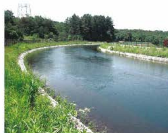
自然環境に配慮して改築された志段味開水路
