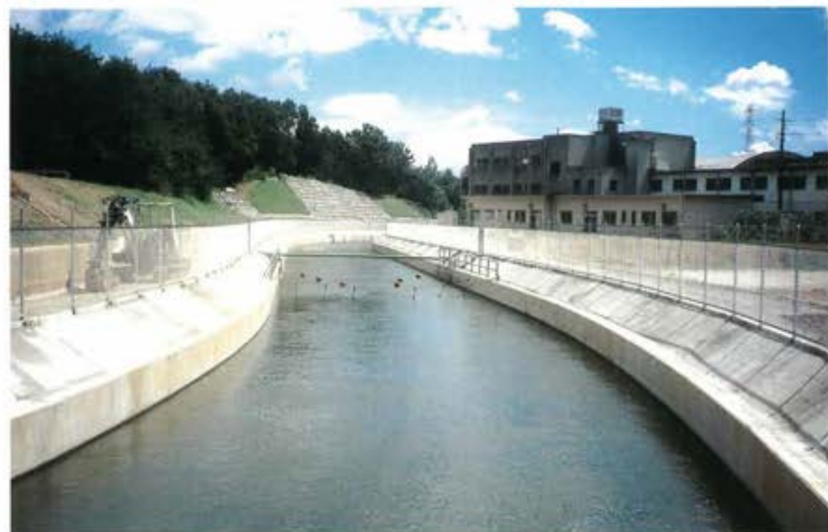
完成した城東開水路
