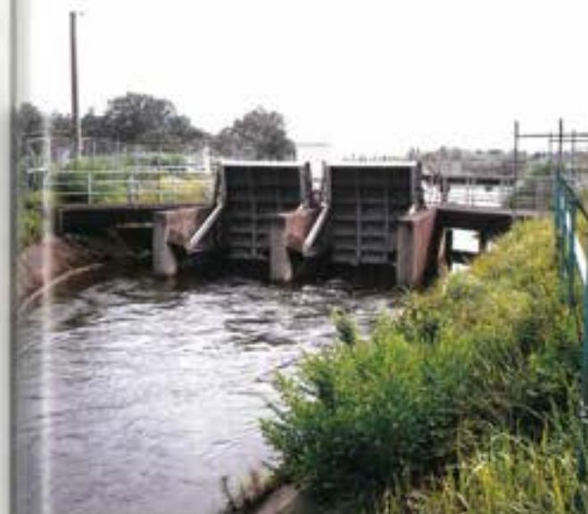
吉川水位調節堰（改築前）
