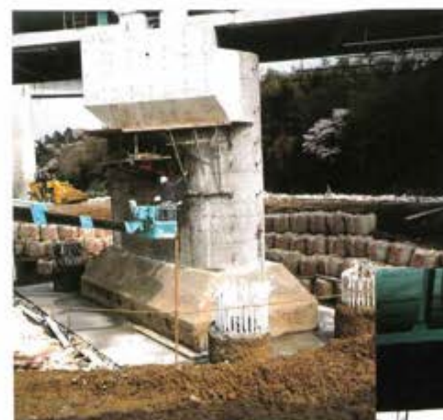
橋脚補強工事中
