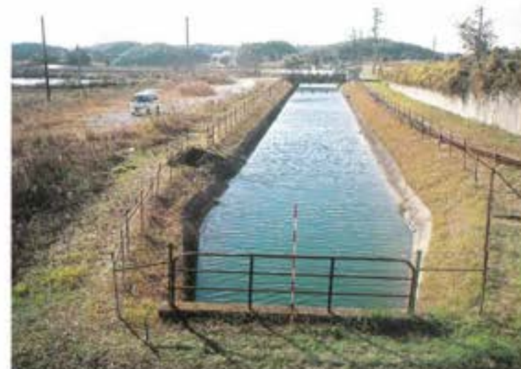
工事前の北池第2開水路
