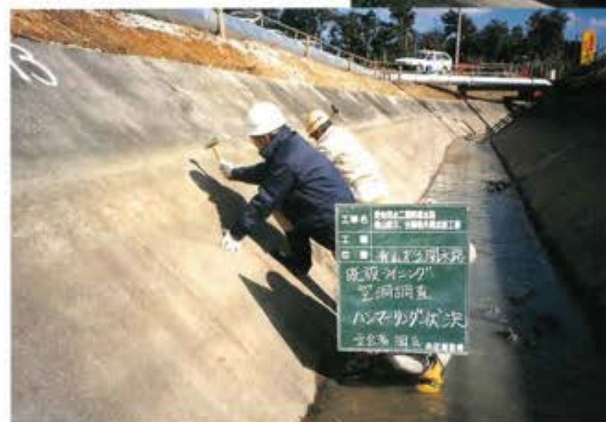
ハンマーリングによる空洞調査
