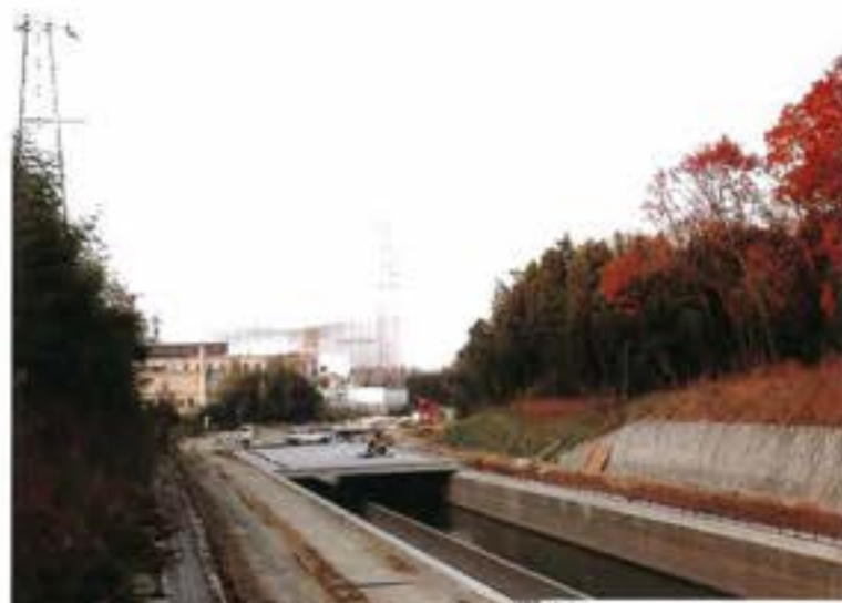
水路に蓋を掛け、水路上部を有効利用するための有蓋化工事中
