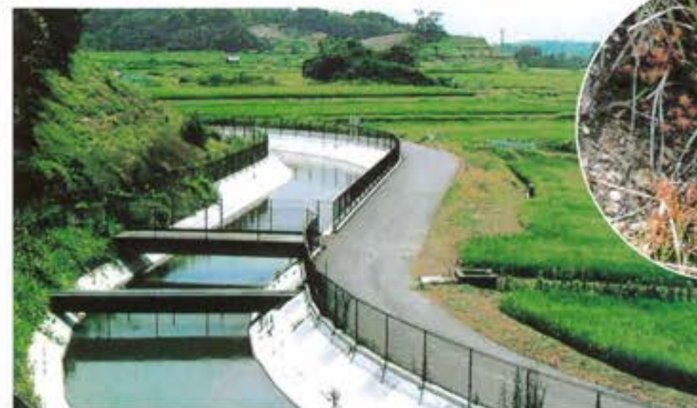
植物の保護に配慮して施工した土取開水路
