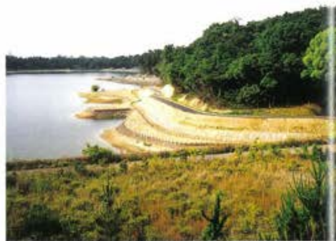
護岸及び周回道路を整備した
