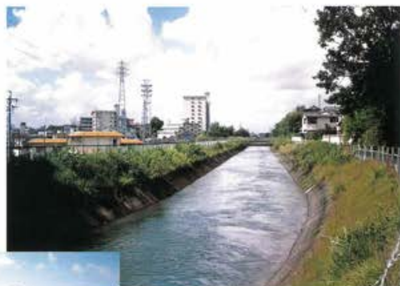
工事前の大将ヶ根開水路
