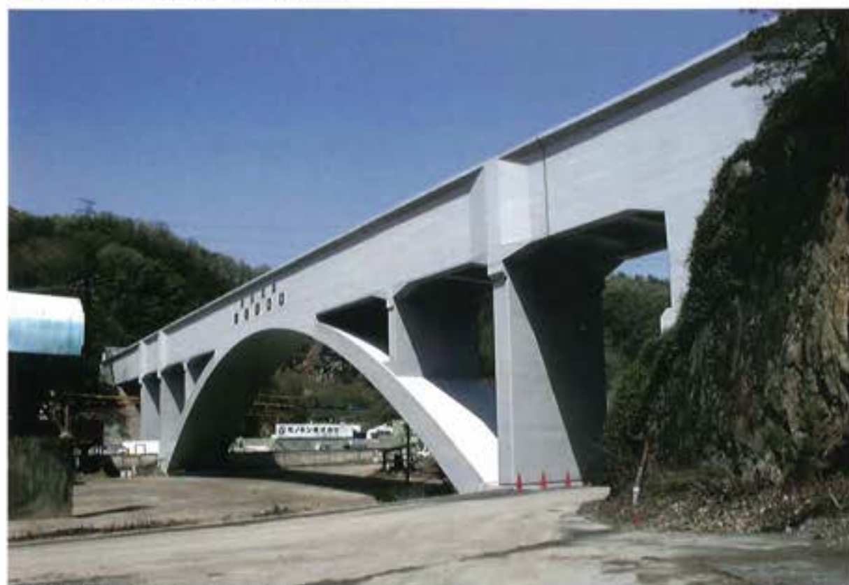
補強・補修等の整備をし、甦った水路橋
