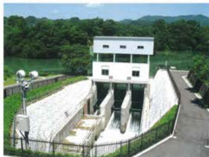
完成したバイパス分流工
