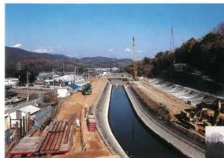
外廻し水路を完成させ（写真右側）、流れを切替える直前の姿
