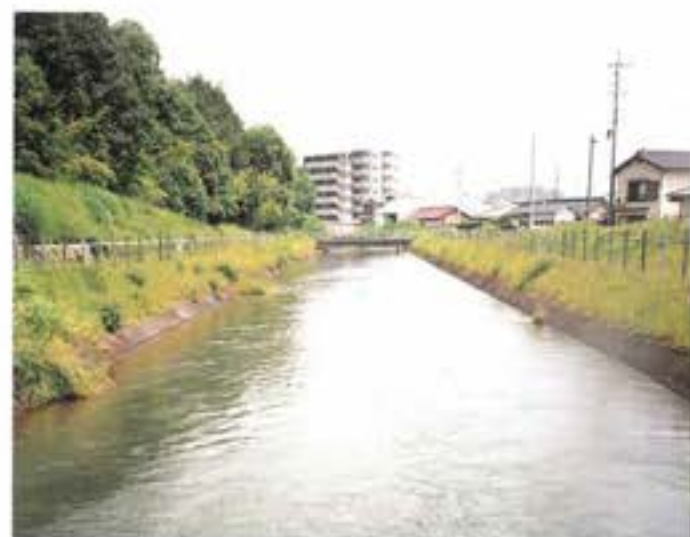
下流部工事前
