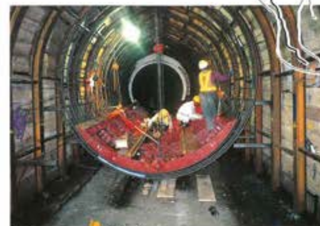
スチールフォーム組立て作業
