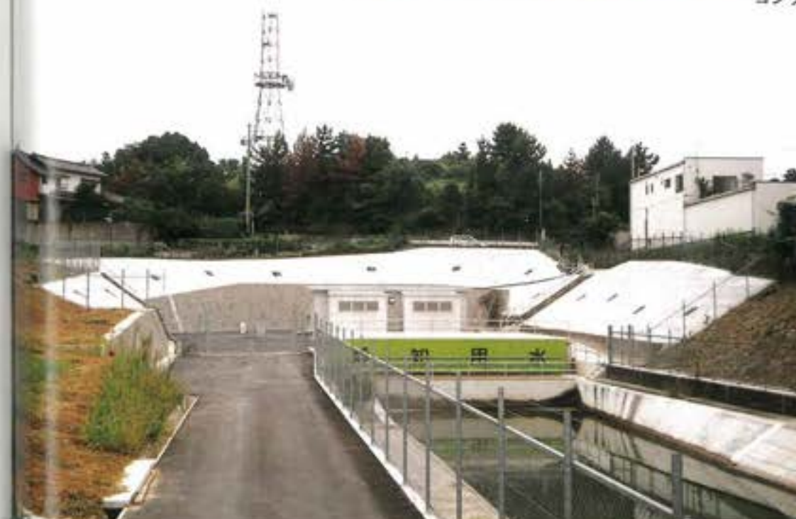
愛知池からの取水バルブを 整備し、静かな流れとなっ た前川開水路
