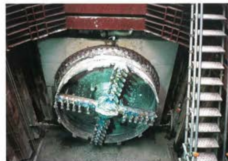
バイパスサイホン工事（シールド機到達）
