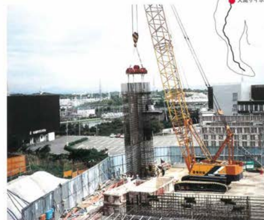
連続地中壁工法による発進立坑工事中
