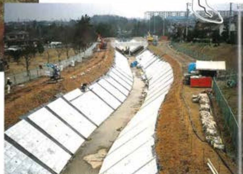
高座山バイパストンネルに流水を切替えて コンクリートブロック上張り工事中
