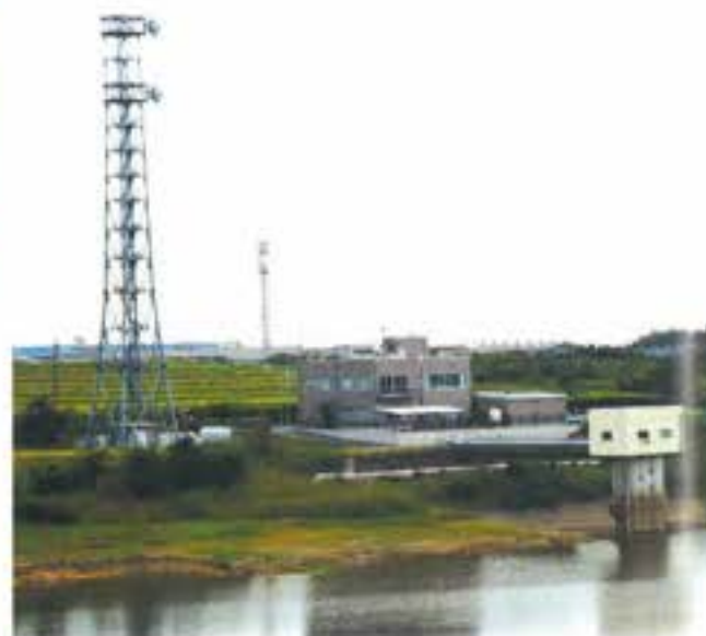
前山池のほとりに新築された下流管理所
