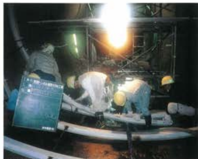
鋼製支保工立込
