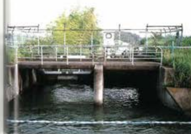
吉川放水工（改築前）
