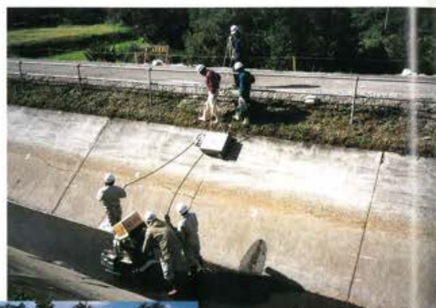
地中探査レーダーによる 空洞調査
