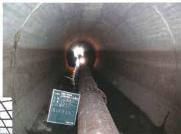
トンネル清掃完了
