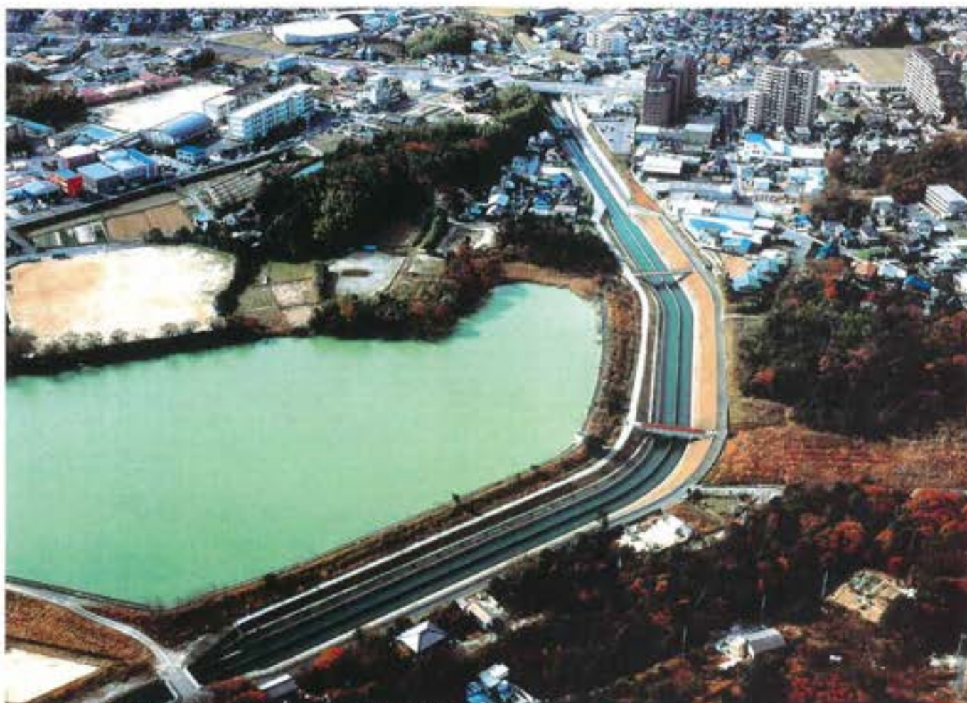
アースライニング部を玉石の再利用等環境に配慮して整備した
