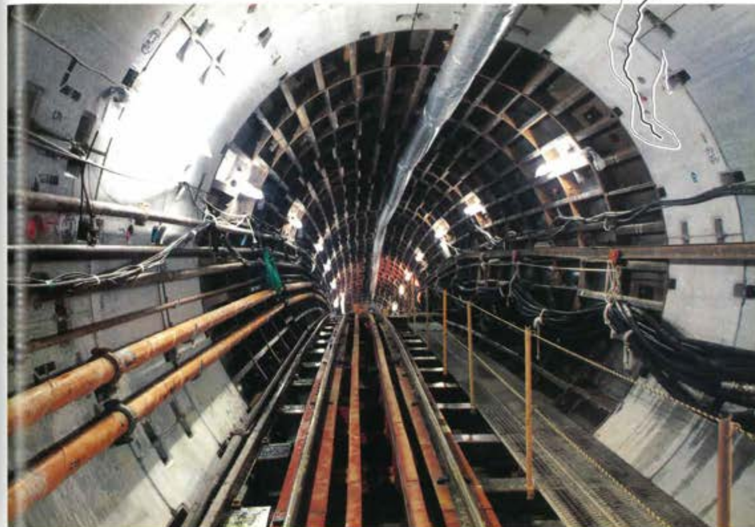
バイパストンネル施工中（急勾配部：下り27%）
