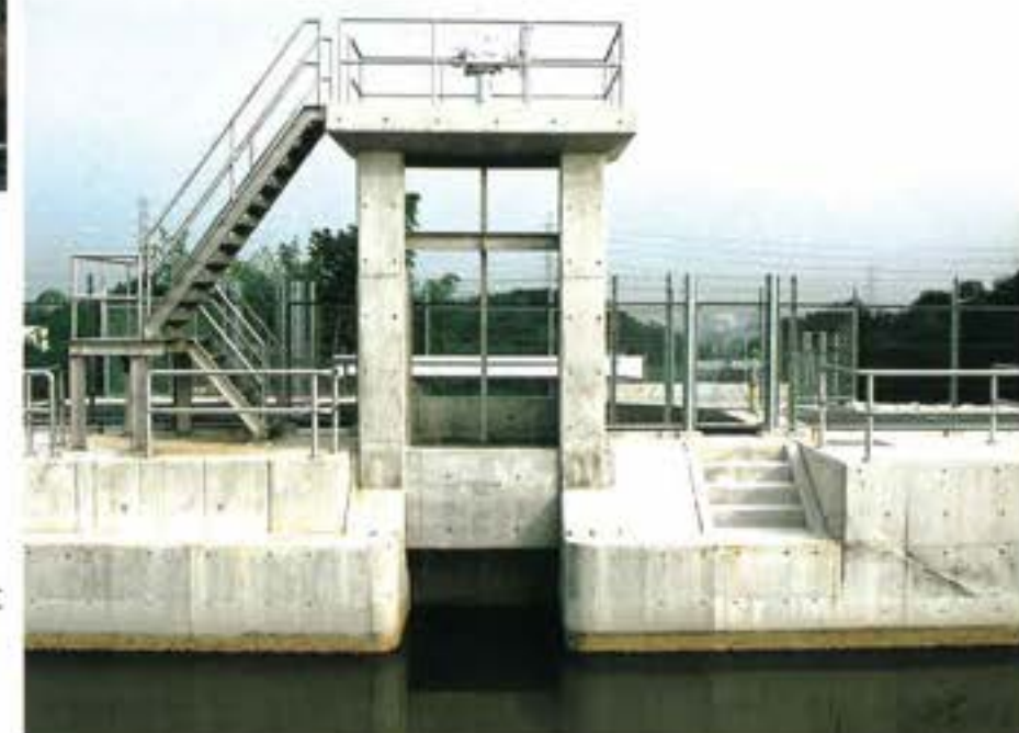
完成した吉川放水工
