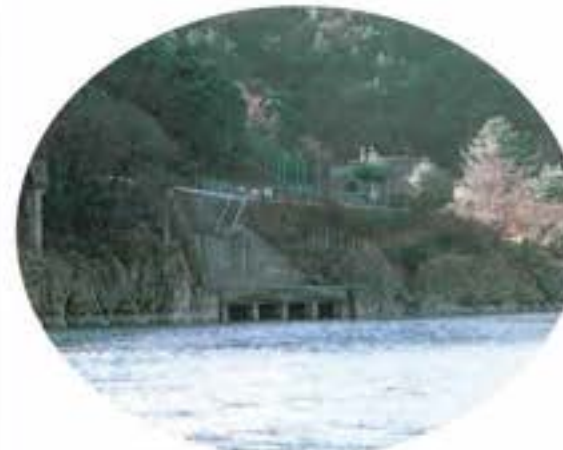
犬山導水の木曾川からの取水口
