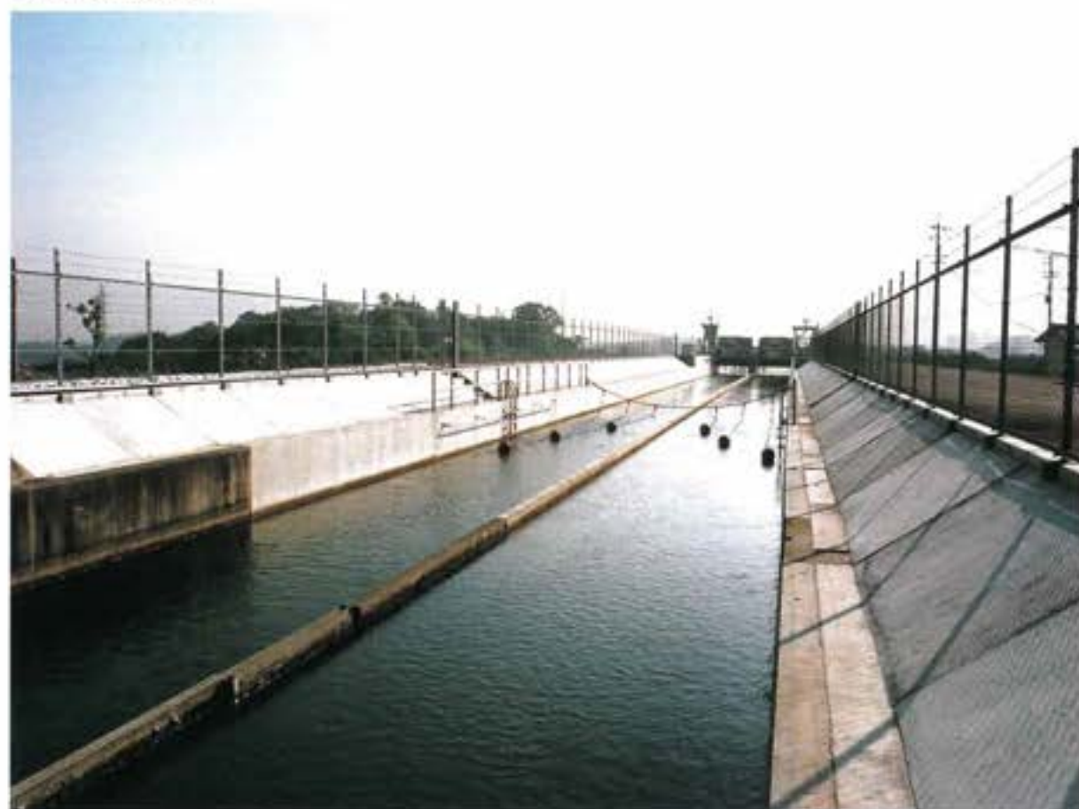
完成した吉川開水路（前方は吉川水位調節堰）
