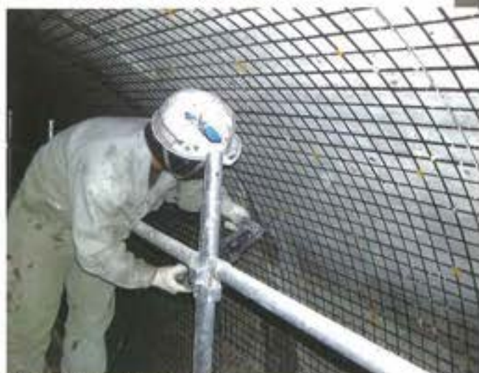
格子状のFRPグリッドを設置
