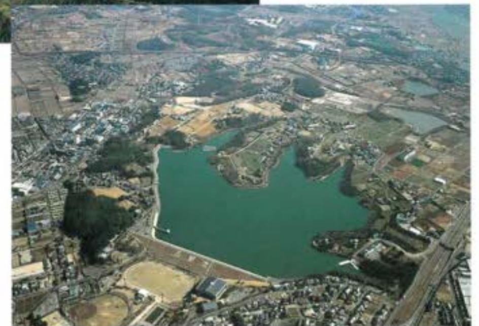
従前からの調整池三好池
