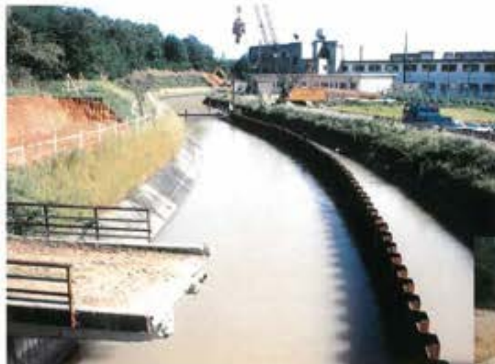
半川締切り用鋼矢板打込み作業中
