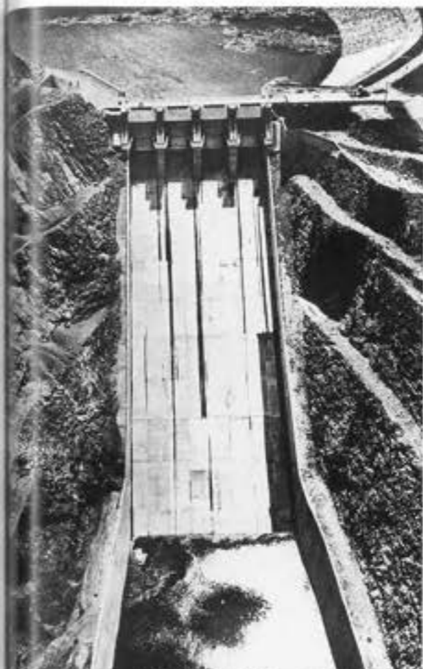
牧尾ダムの余水吐はシュート式で、溢流堰の上に4門のテンダーゲート(1門10m×10m)を設置。この余水吐のために掘削された大量の岩石は、ダム本体のロック層に利用するという合理的な工法がとられました
