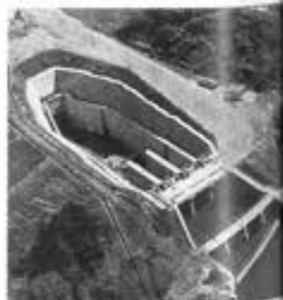
工事中の兼山取水口
