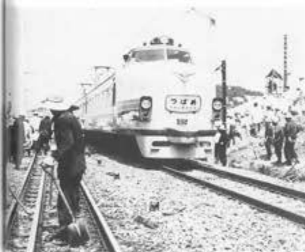
東海道本線を潜り抜ける大高サイホンの工事
