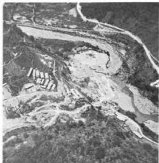
建設中の三尾発電所
