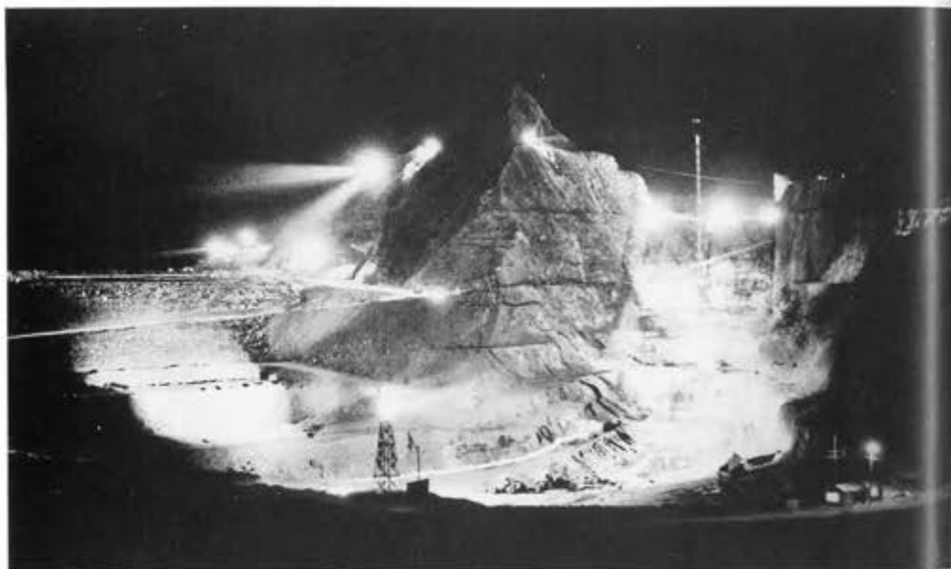
工事は夜も続けられるという突貫工事でした
