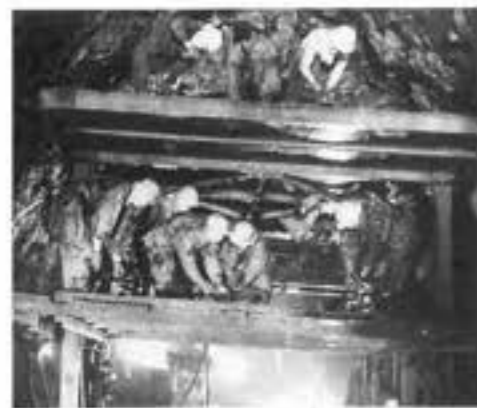
トンネル内で働く作業員たち
