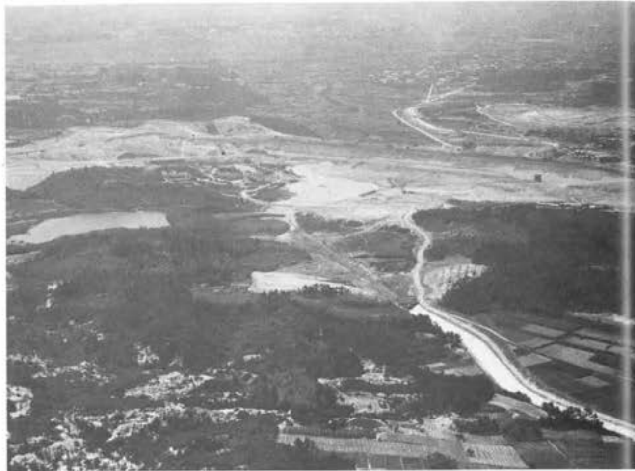
■上流部からみた調整池ダム(建設中)
