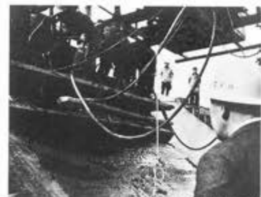
スロープフォームによる水路舗装工事
