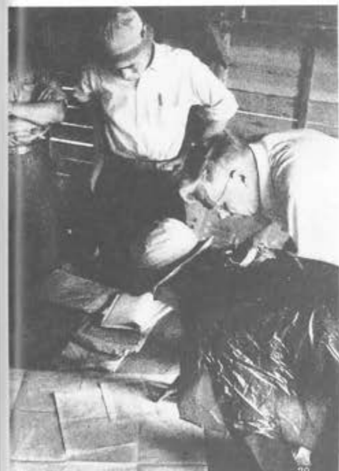
現場の詰所で計画図を広げて共同ディスカッション
