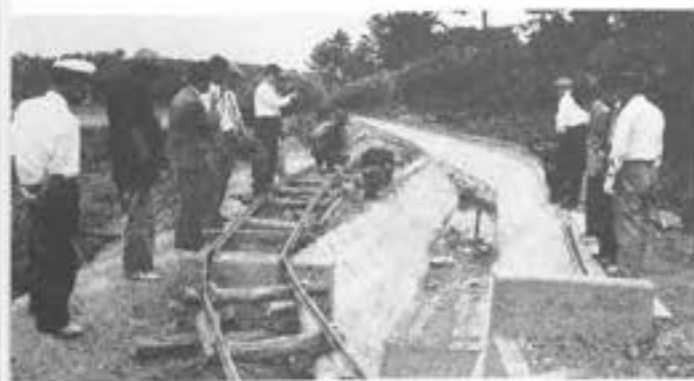
曲り池分線で施工状況を見る
