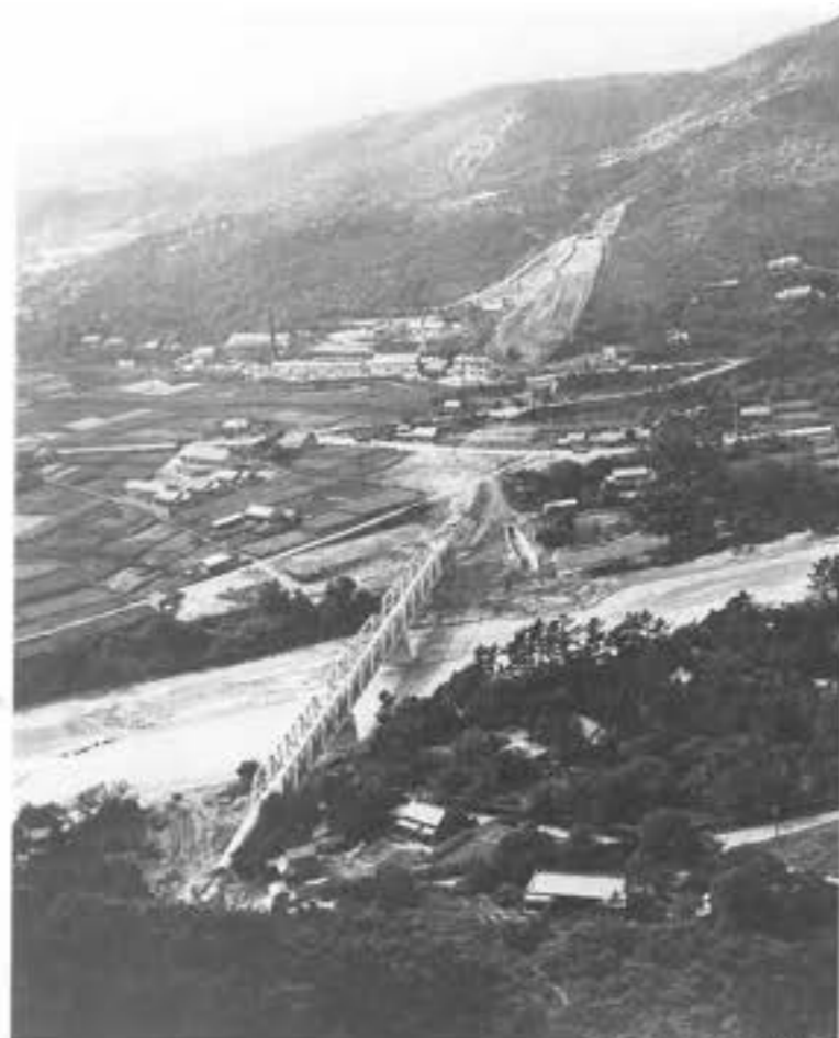
上から見た高蔵寺サイホン
