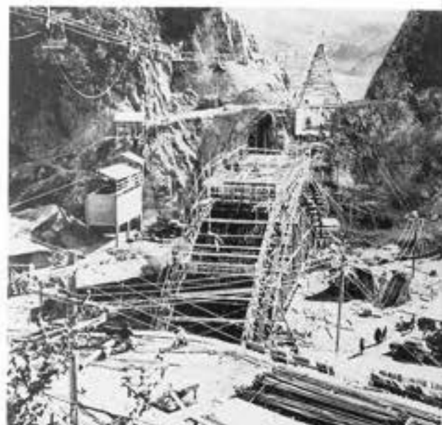
支線水路橋の下部工事
