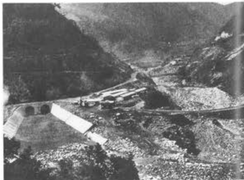
下流側仮橋切堤の工事現場
