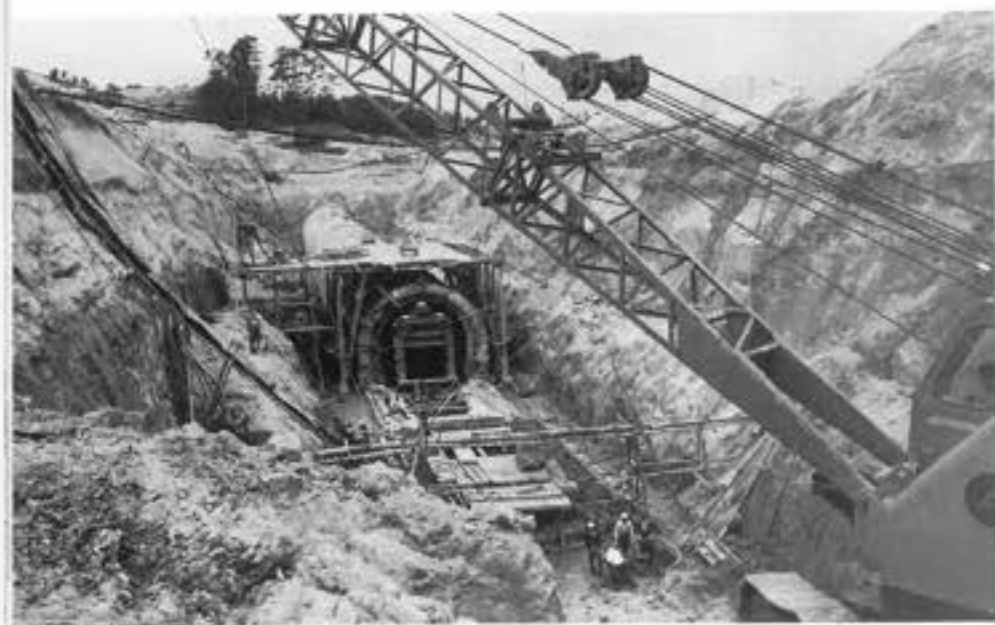
キャリアオールスクレーパーによる掘削でスピードアップ
