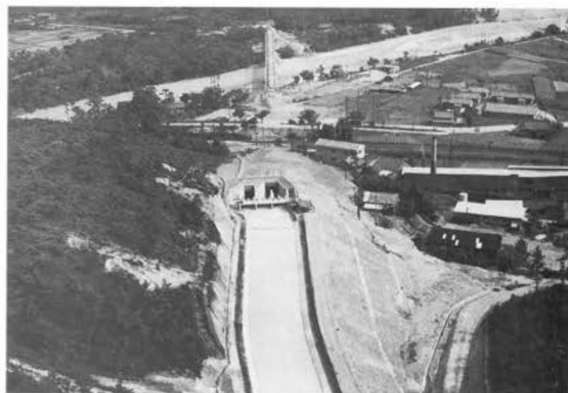
高蔵寺サイホンの入口と鋼管橋
