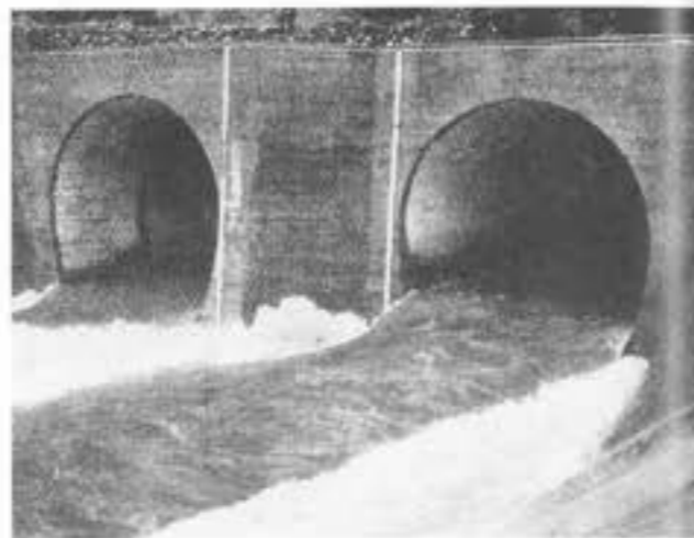
バイパスの出口部(上は開水路、下は出口)
