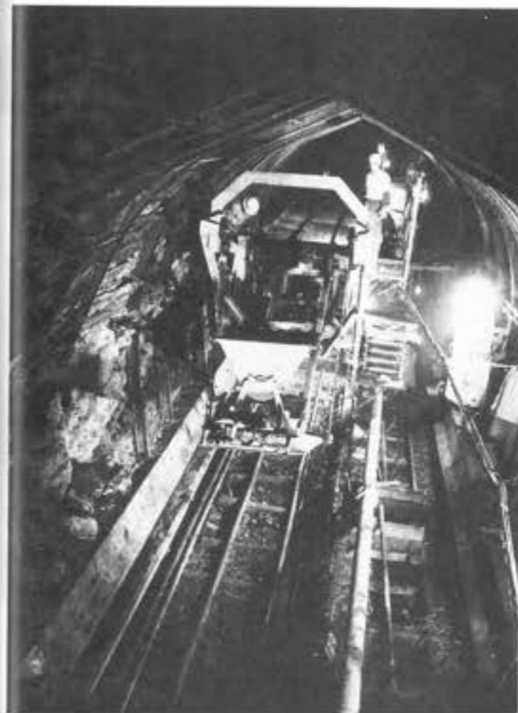
白山トンネルライニング
