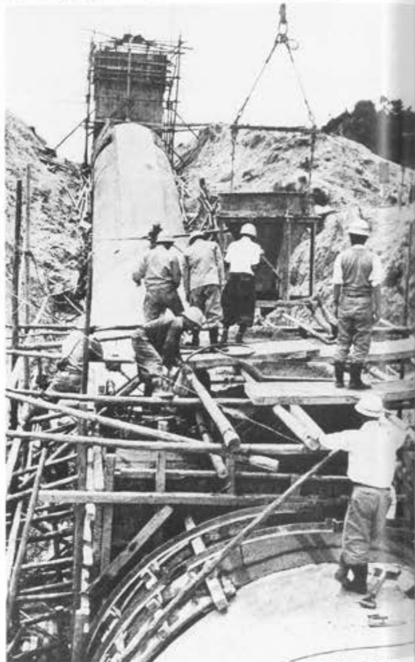
サイホンの最終接続部の施工
