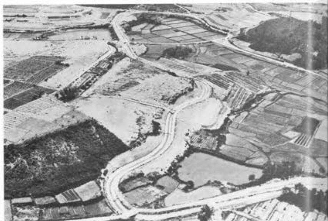
上から見た支線水路
