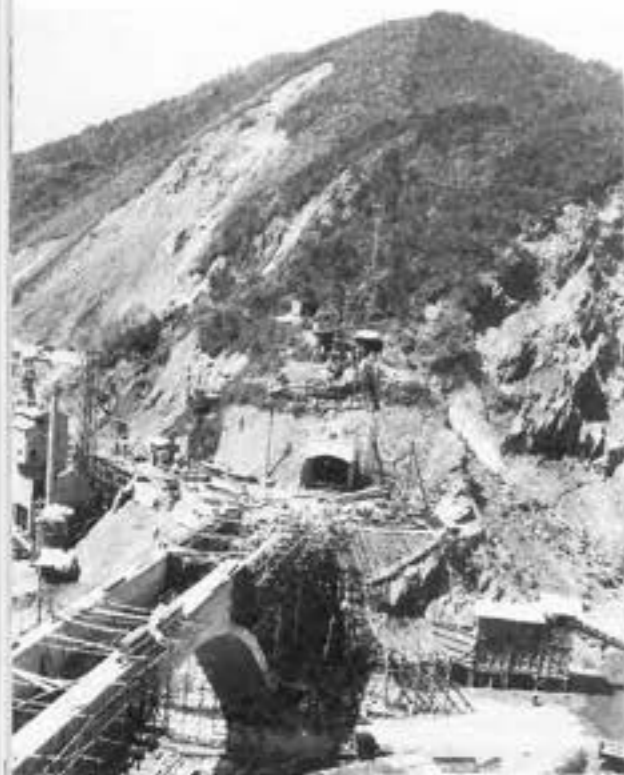
入水路橋のコンクリート打設
