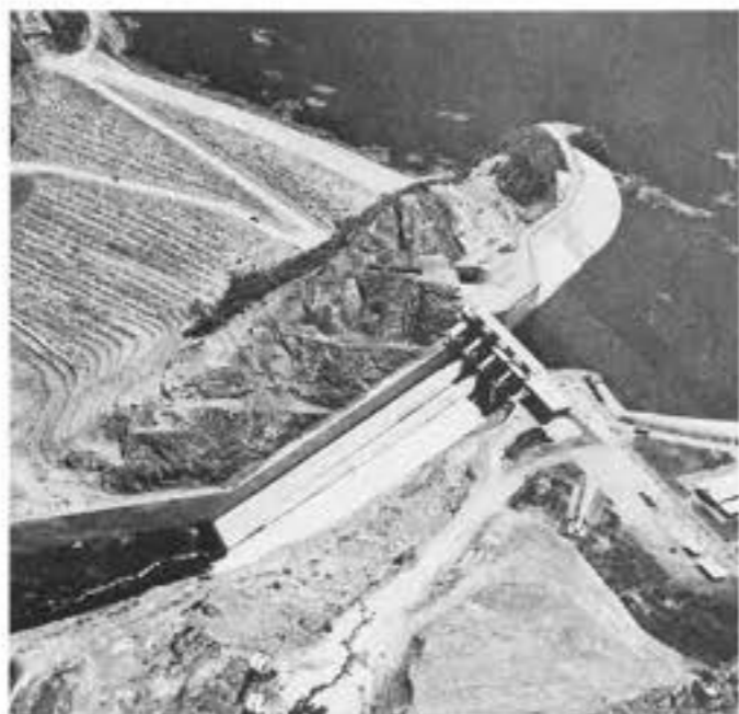
完工した牧尾ダム
