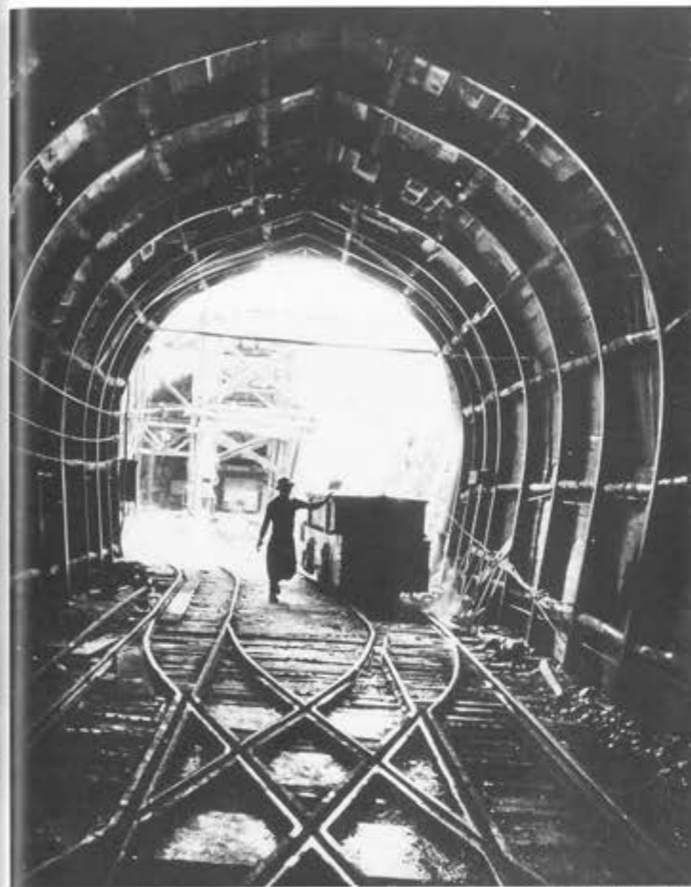
兼見トンネルの工事現場
