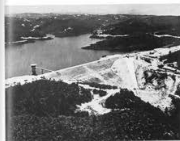
建設中の松野池
