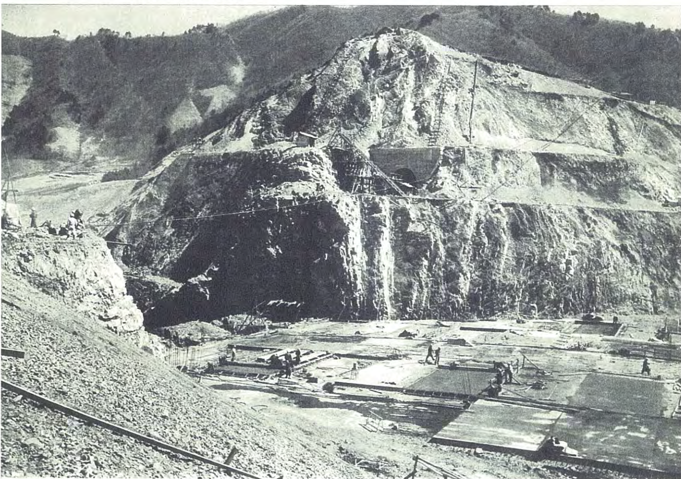
開始されたコンクリート打設
