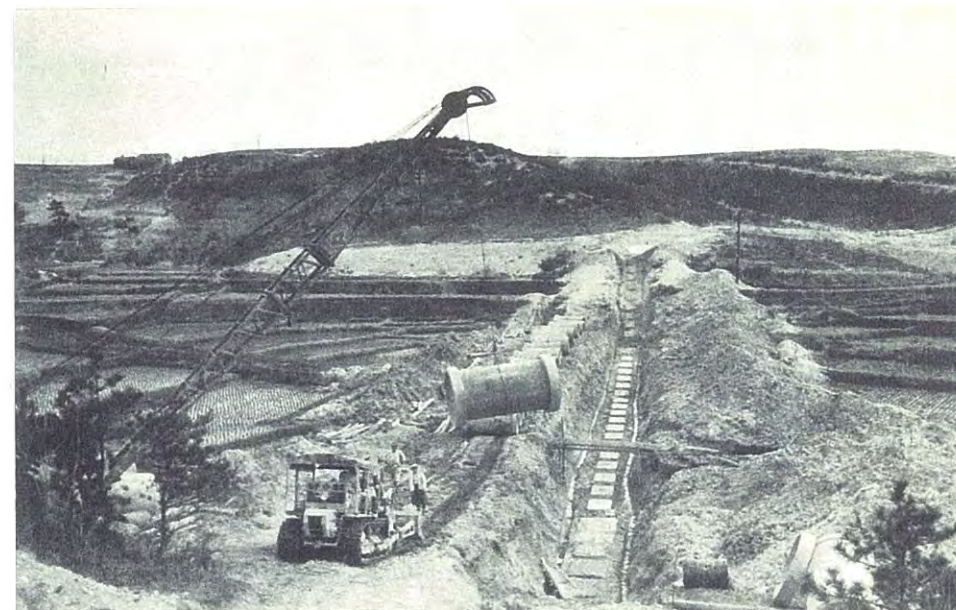
サイホン工事
