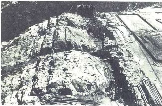
掘削を終った余水吐の溢流堤頂部
