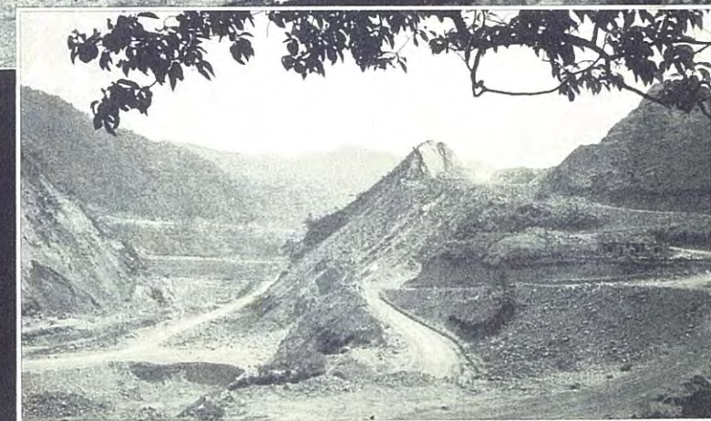
▶ 34年夏、仮締切ダムを完成した当時の牧尾ダム
