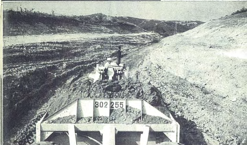
▼ショベル、ブルドーザー、スクレーパーなどで掘削し整形する。
