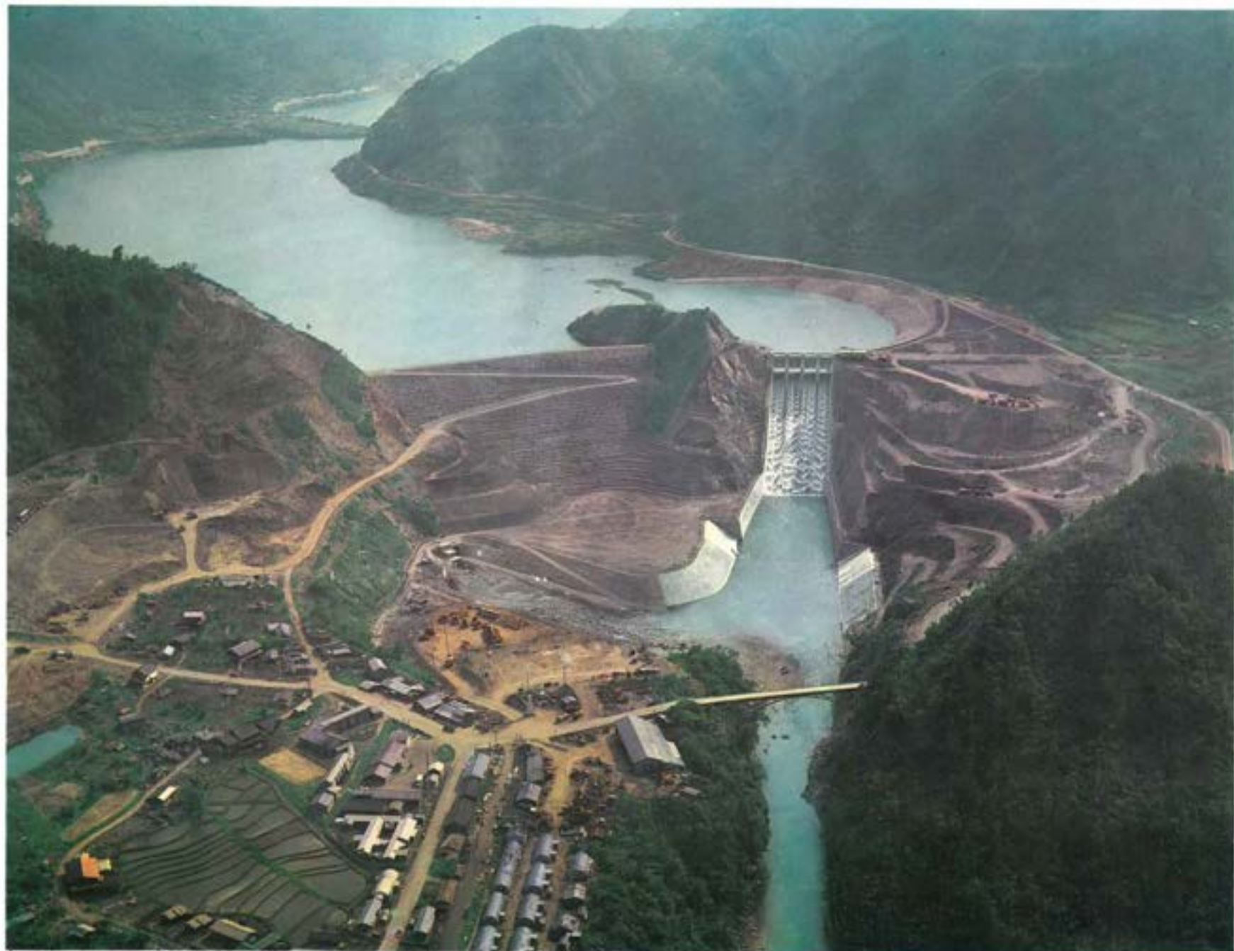
■下流側からみた牧尾ダム（中央がダム本体、その右が余水吐）
