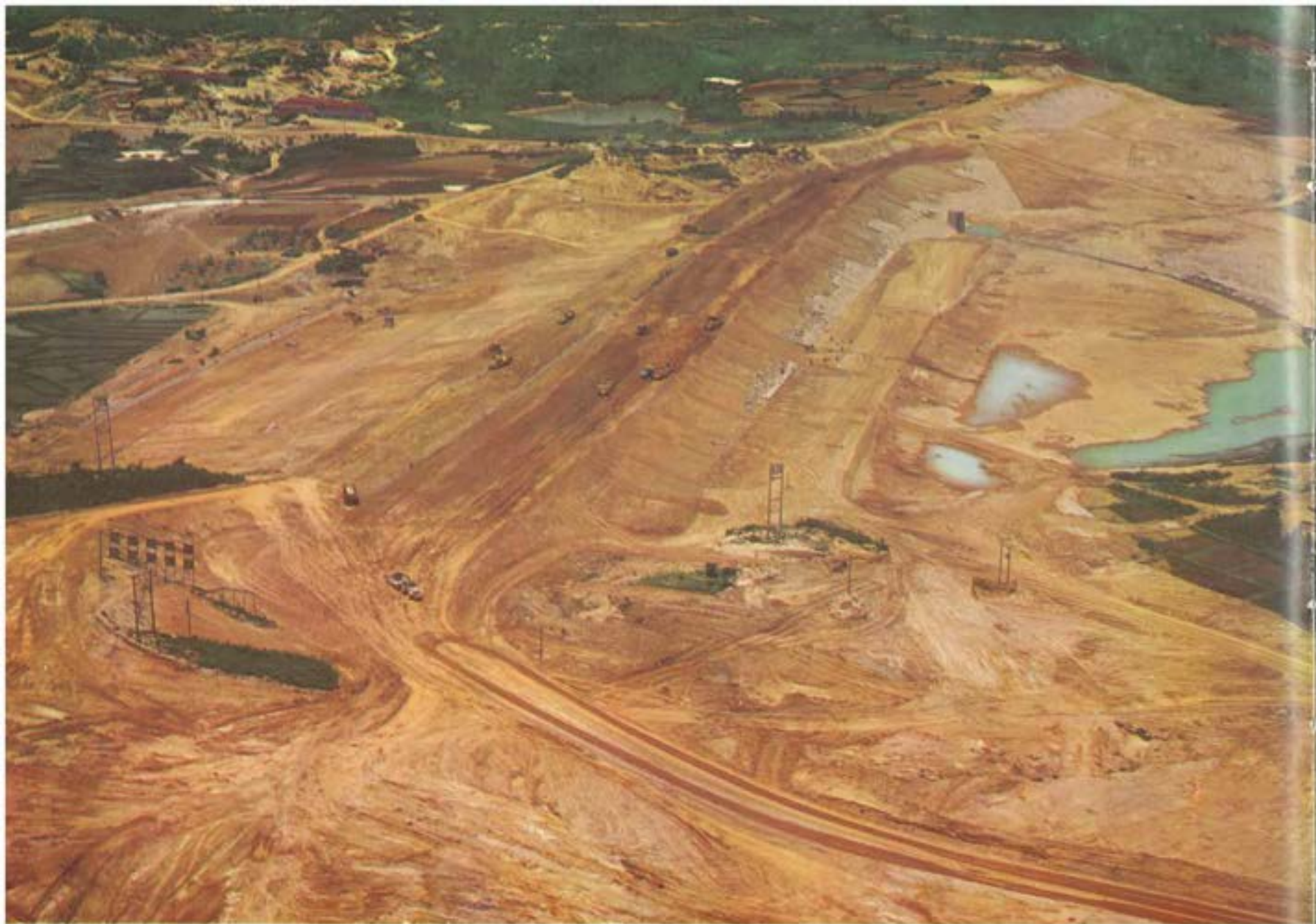
■左岸上空からみた建設中の調整池ダム
