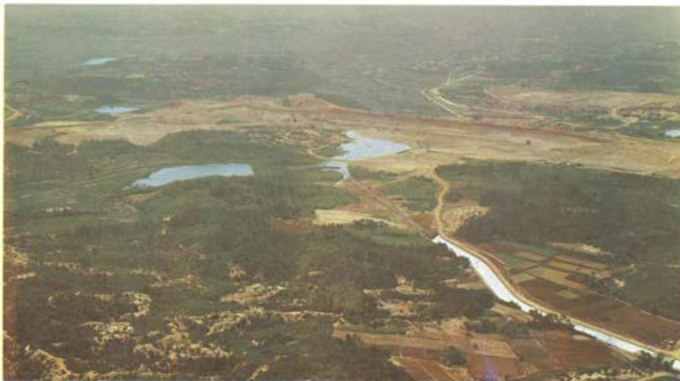
■下流部からみた調整池ダム
