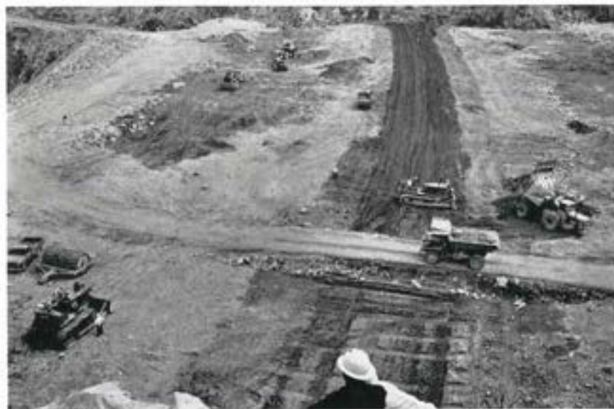
■築堤工事（中央の黒い部分が中心コア）
