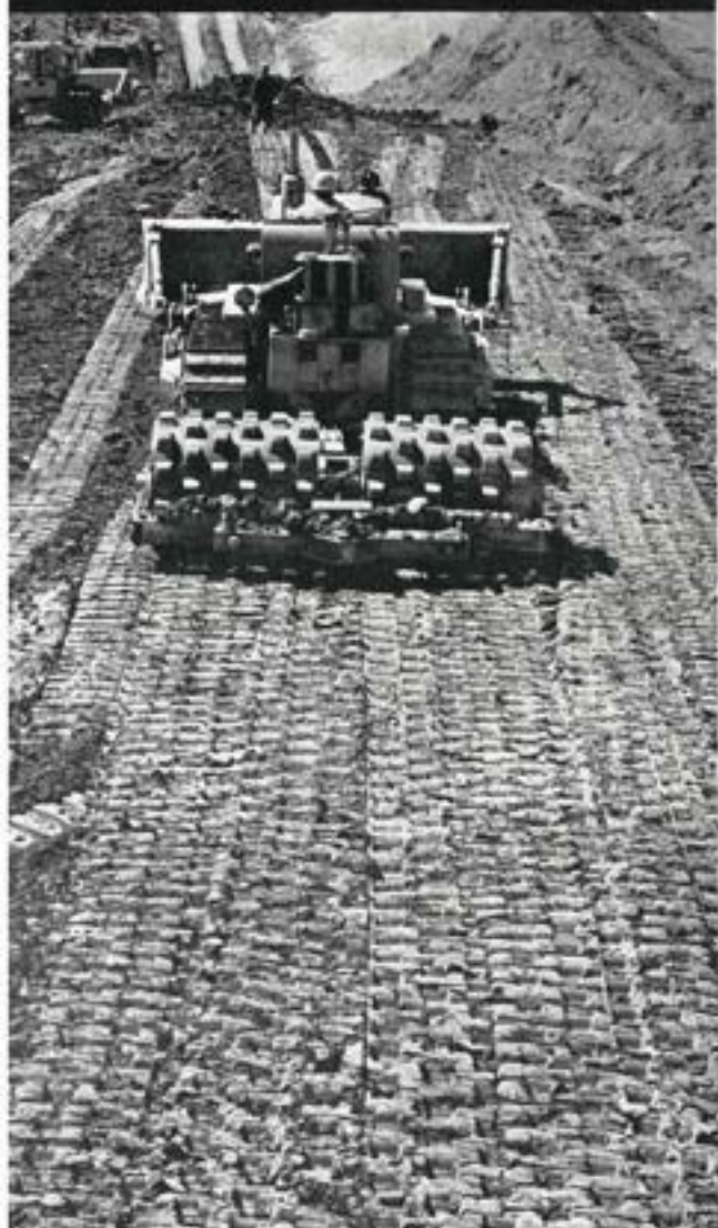
① 毎日締め固めのおわった箇所から供試材料を採取する
