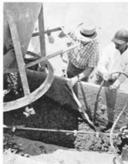
■バイブレーターを自から操作してみるビビアン技師 Mr. L. F. Vivian, Engineer operating a vibrator for himself.
