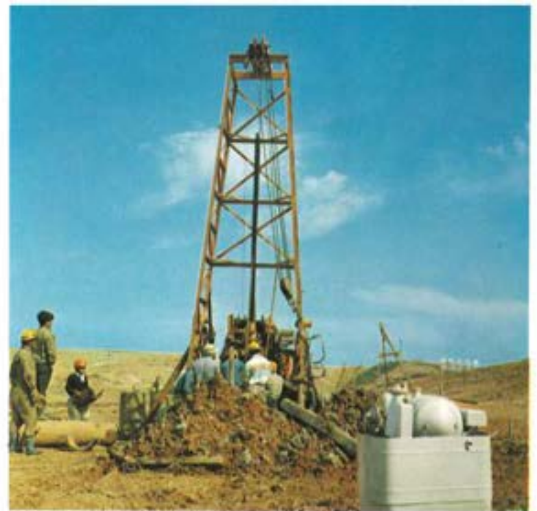
■アースダムの堤体内部に各種の測定計器類が埋設される（調整池ダム）
