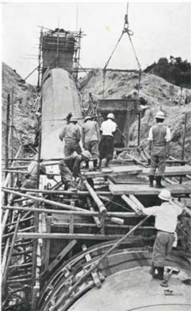
■サイホンの最終接続部の施工
