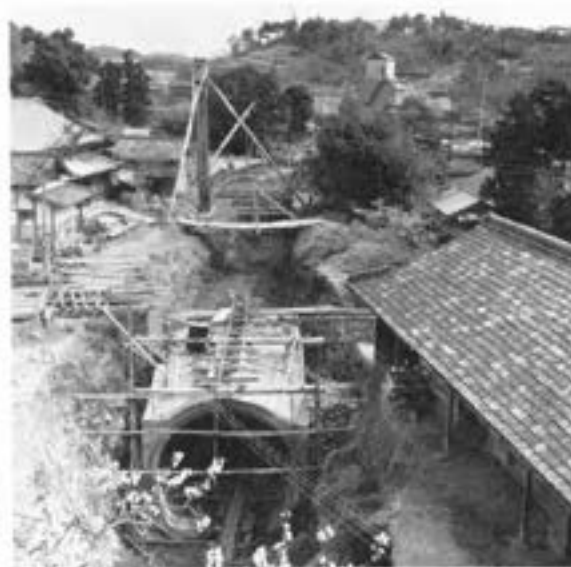
■農家の前庭で進められる暗渠工事。工事がおわれば原状にもどされるが、それにしても起工承諾をとるまでがたいへんな苦勞である
