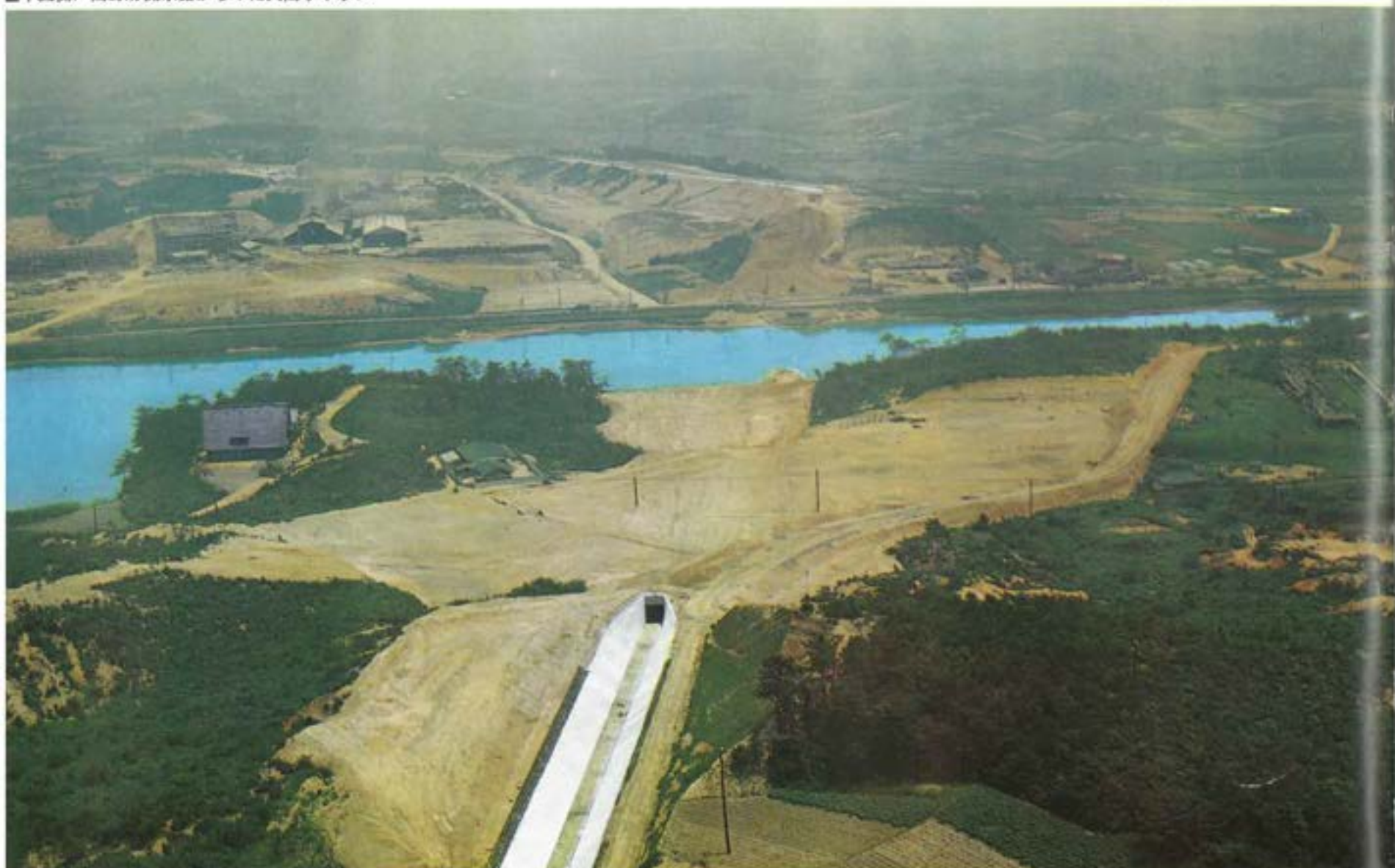
■下流側、高野府開水路からみた大高サイホン
