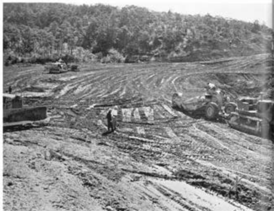
■幹線水路の路盤締め固め
