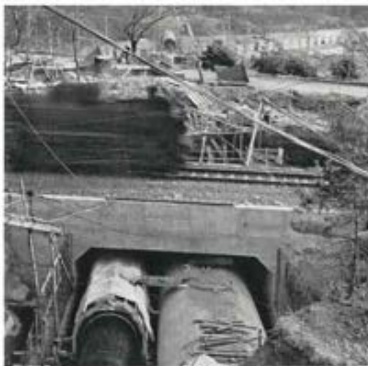
■中央本線の下を潜る工事中的高蔵寺サイホン、右が本水路、左は余水吐
