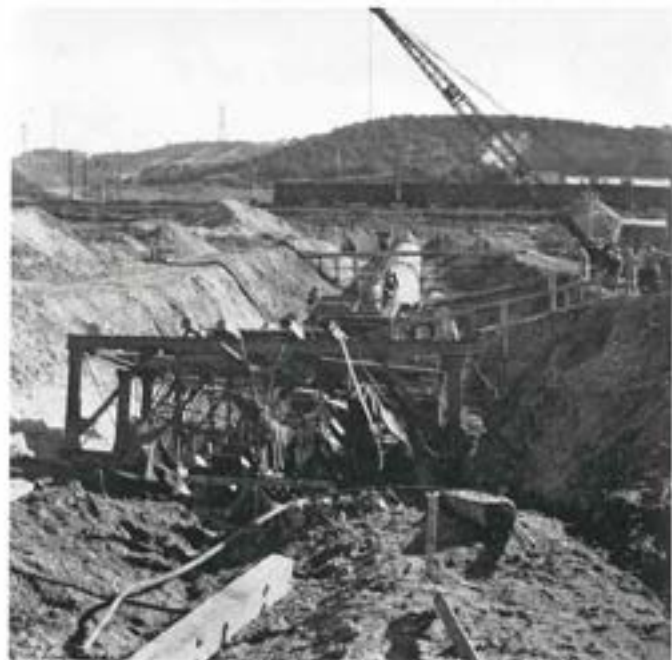
■工事中の大高サイホン（下流側から）
