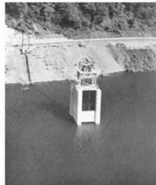
■ 牧尾ダムの発電用取水塔
