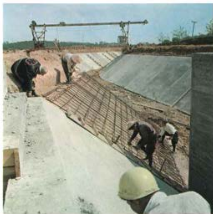
■開水路の付帯構造物の施工
