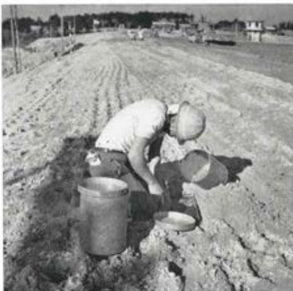
① 毎日締め固めのおわった箇所から供試材料を採取する
