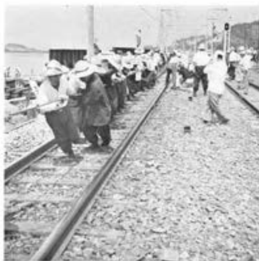
①綱引きではない、エッサエッサの掛声もろともレールのてっぺ
