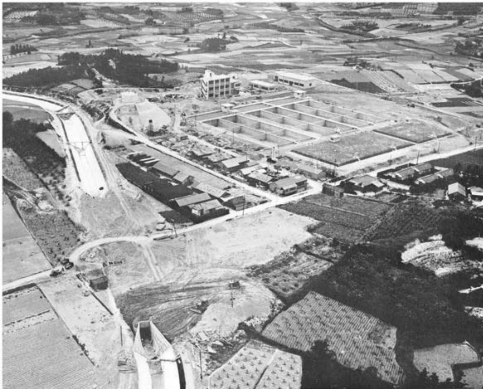
■愛知用水幹線の そばで建設進む 浄水場(上野)
