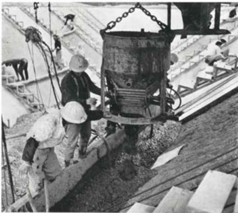
■スロープフォームによる開水路のコンクリートライニング。現場打設のコンクリートについては毎日強度試験が行なわれる
