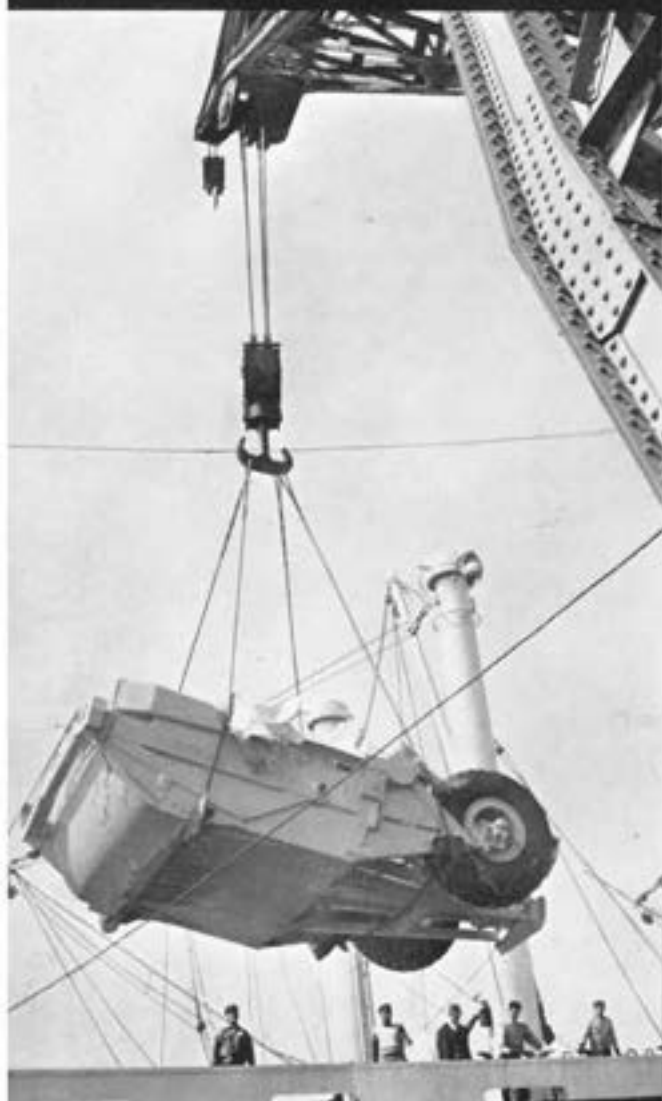
■輸入機械の陸揚げ (名古屋港)
