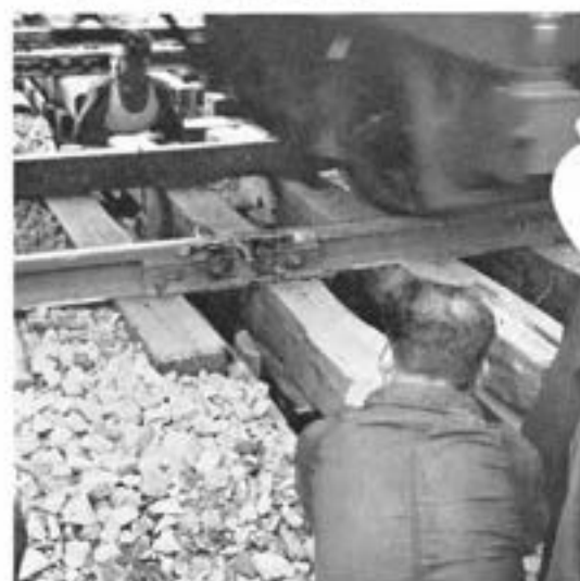
⑥レールの縫ぎ目にじっと見入る工事関係者、列車が無事通過するとさすがに皆ホッとする
