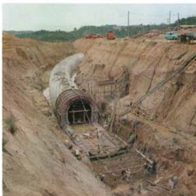
■軟弱な地盤を克服しながら暗渠の巻立
