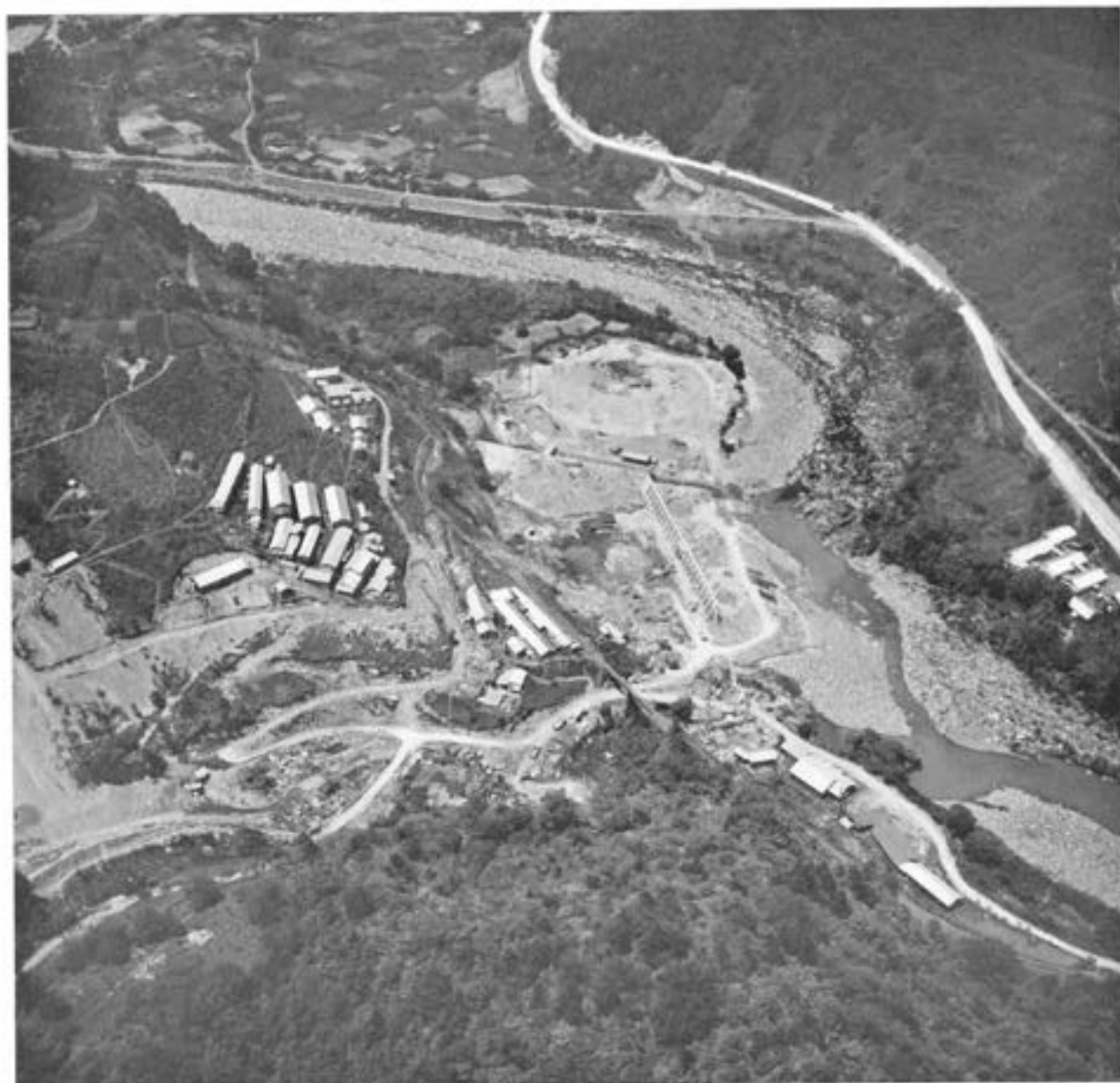
■ 建設中の王滝川発電所
