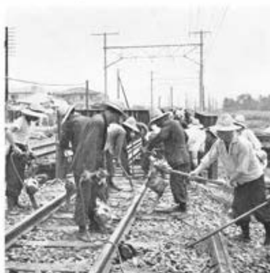
④レール敷設完了、パイプレーションで路床を固める、この間も上下列車はひっきりなし
