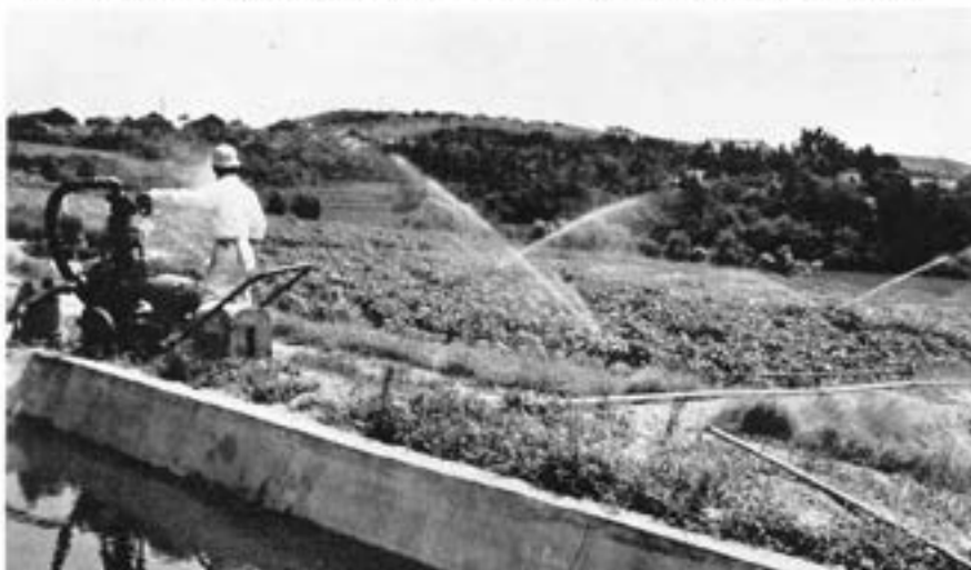
■ファームボンドを利用してポータブルポンプによるスプリンクラーかんがいの試験
