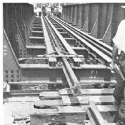
③横けた架設完了、次はレール敷設。うまく合いますかナと素人の気をもませる一瞬
