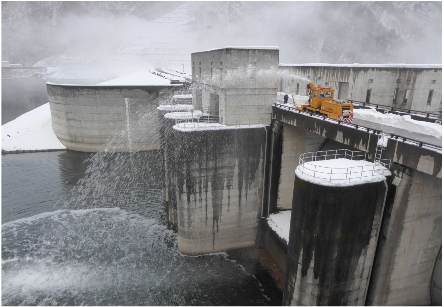
徳山ダム(岐阜県揖斐川町)
