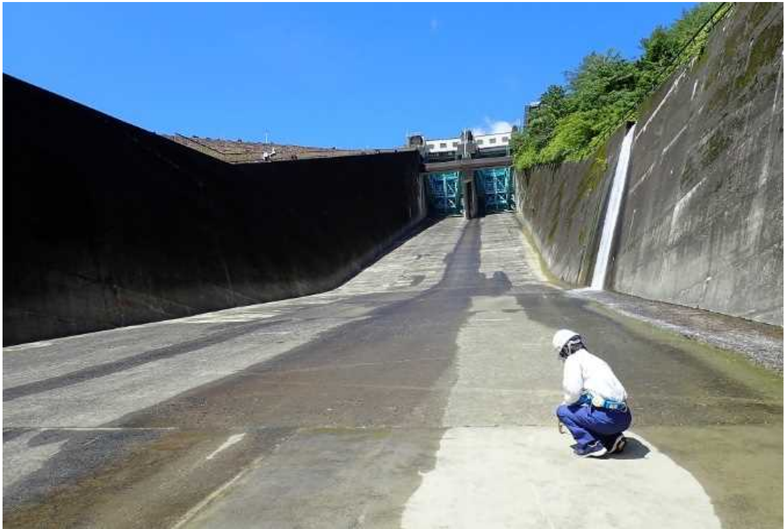
岩屋ダム(岐阜県下呂市)
