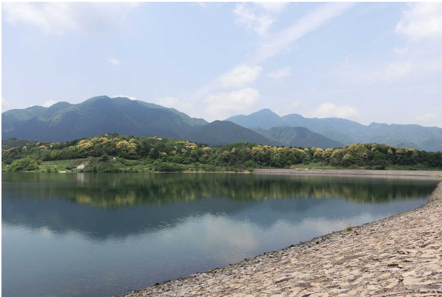
三重用水菰野調整池(三重県菰野町)
