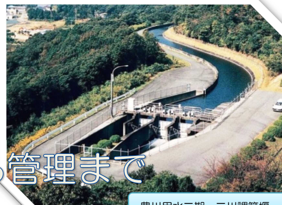
豊川用水二期 二川調節堰
