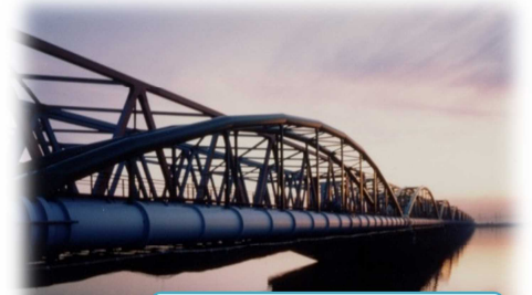
木曾川用水 木曾川水管橋
