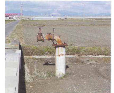
井戸の抜け上がり状況 三重県桑名市 木曾岬町緑源輪中 (平成23年3月)
