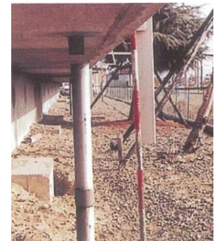
深基礎をもつ建物とその周辺の土地の沈下の差により、ベランダの支柱は宙に浮き、配水管は継ぎ足しが必要となっている。
