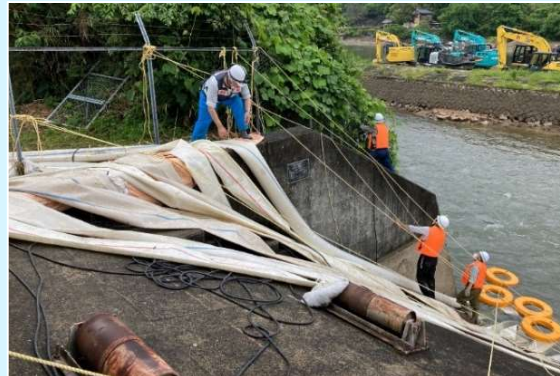
仮設ポンプの維持管理 (ポンプ運転、破損ポンプの交換作業等)
