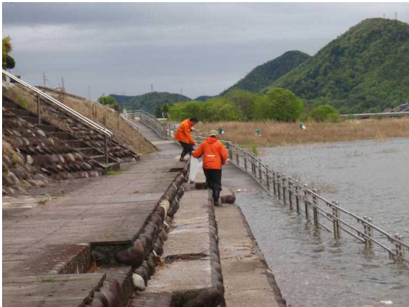
前日からの降雨により増水
