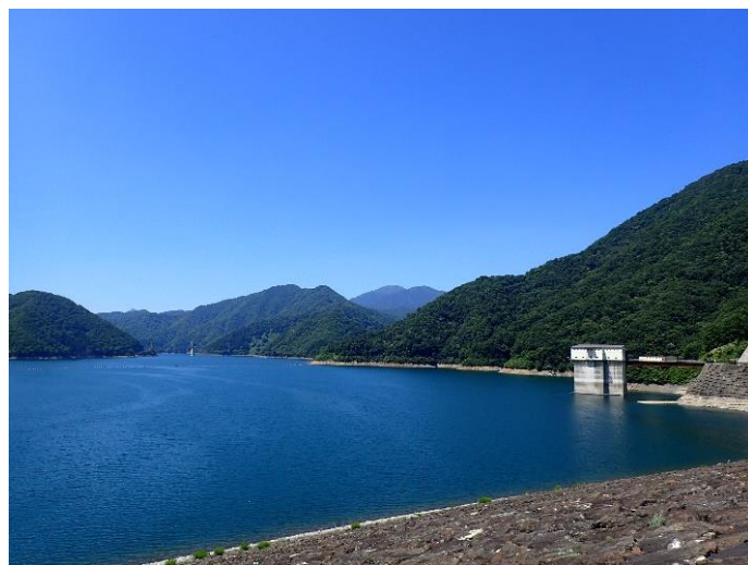
■ 堤体から徳山ダム湖と選択取水塔を望む
