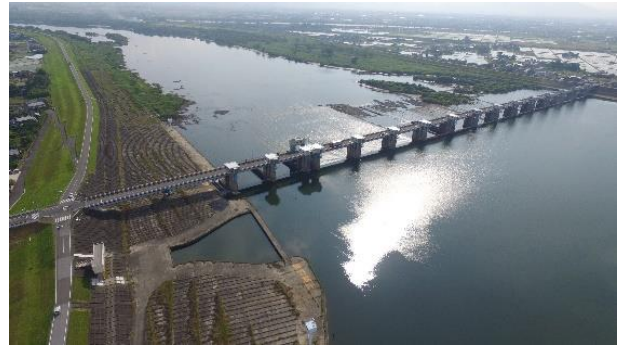
■上空から見た木曾川大堰全景
