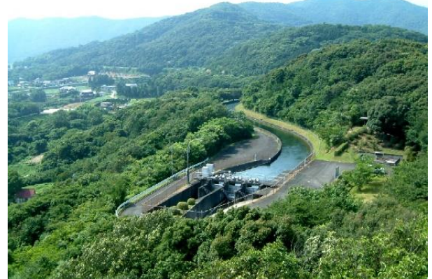
■豊川用水施設 二川チェック
