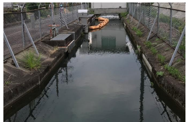
■フラッシング後の開水路
