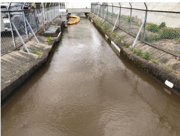
■フラッシング中の濁っている開水路
