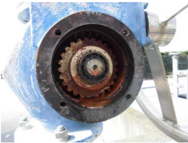
■ 開閉機内部（発錆、水分混入）
