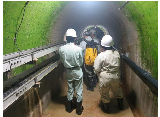
■堤体内を点検する就業体験生
