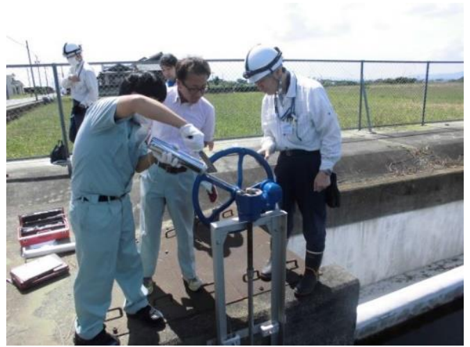
■ 開閉機へのグリス給油
