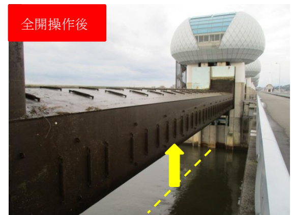
■左岸側管理橋からゲート開閉状況を望む
