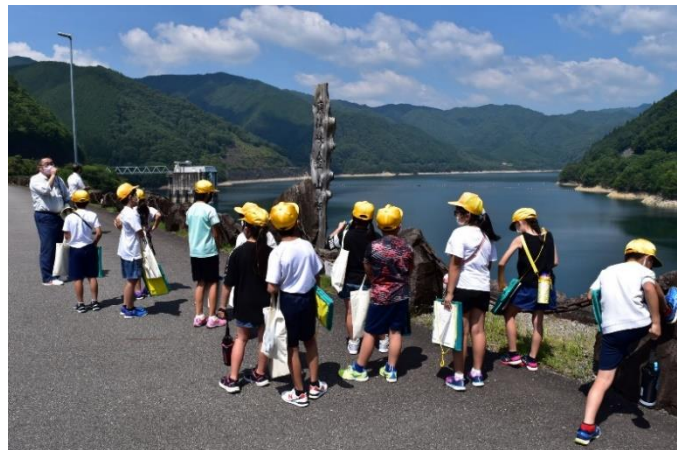
■ 堤体でのダム説明
