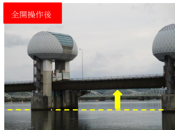
■左岸下流からゲート開閉状況を望む
