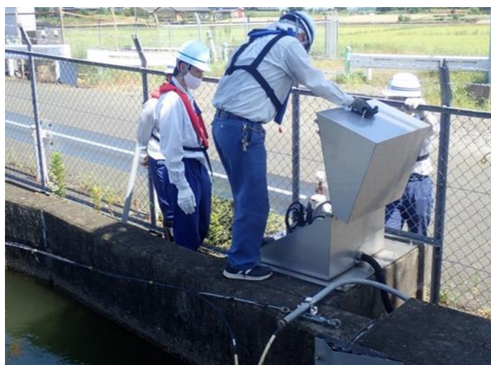
■巡視、点検実習
