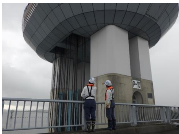
■一次点検（ゲート点検）
