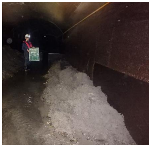
■トンネルの下流に移動した土砂
