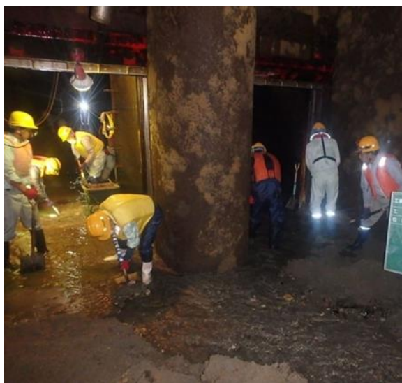
■土砂移動作業
