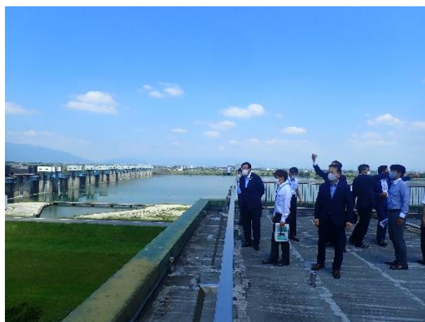
■大堰・幹線水路視察
