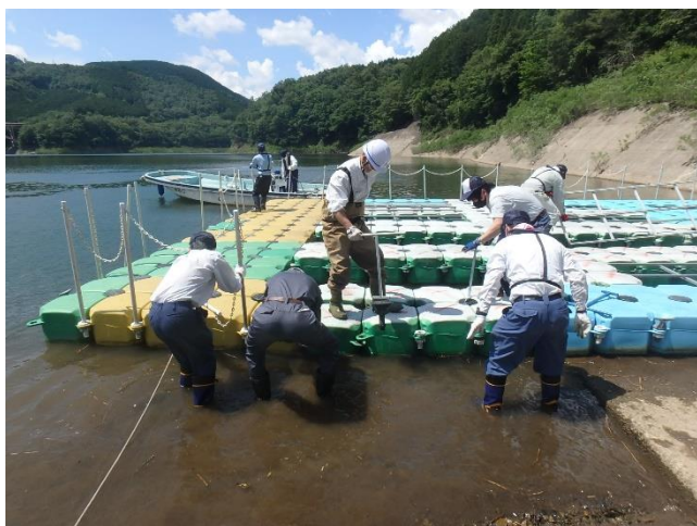
■フロート交換作業
