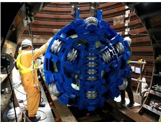
■現場納入時のシールドマシン
