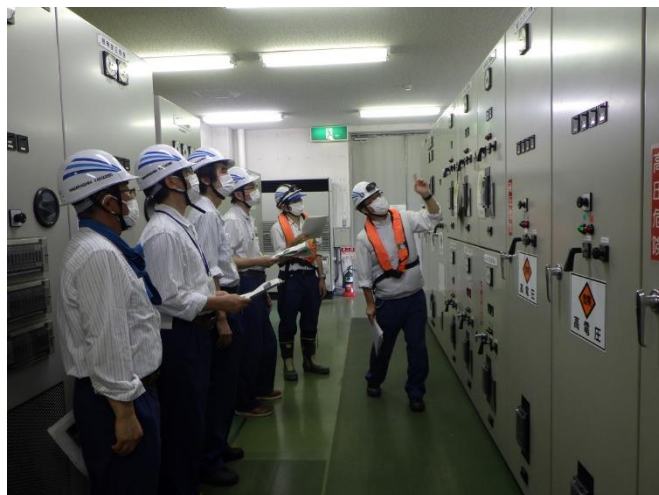
■電源・通信ケーブルのルート切替訓練
