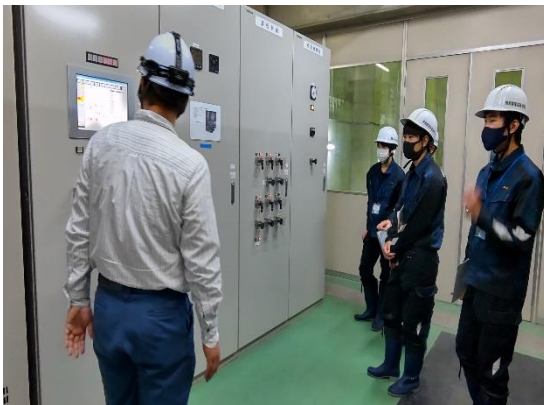
■電気設備点検
