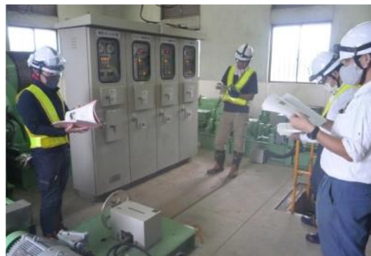
■加佐登調整池での設備点検状況
