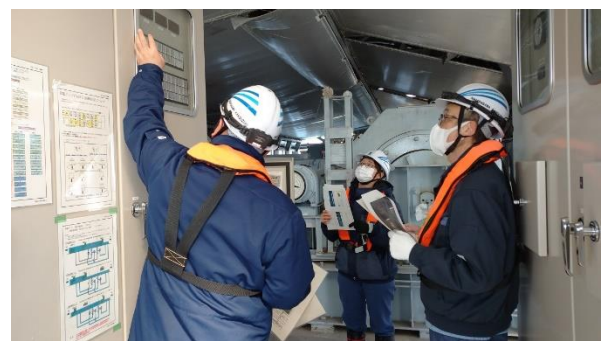
■ 除塩ポンプの機側操作訓練
