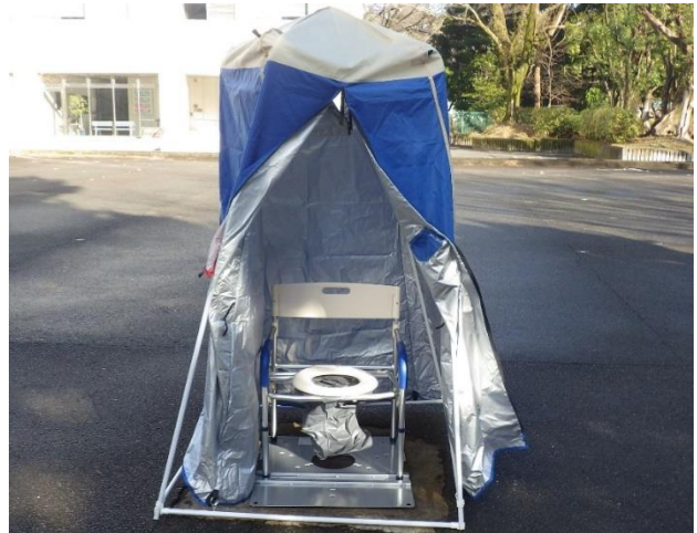
■完成したマンホールトイレ
