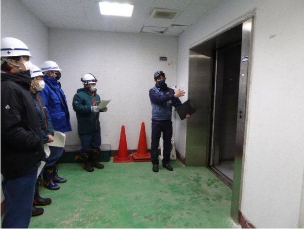
■ 堤体内エレベータの説明を受ける職員
