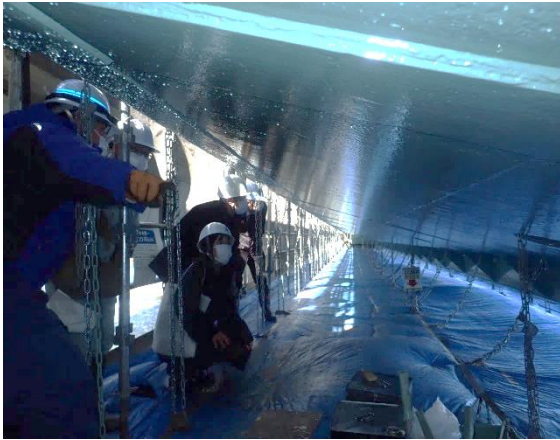
■ ゲート扉体の状態確認
