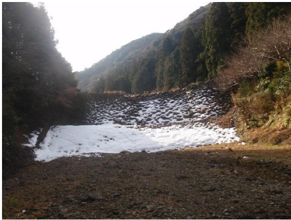
■羽根谷砂防堰堤（第一堰堤）
