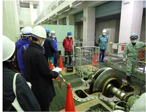
■ ポンプ設備の整備状況確認
