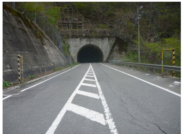
■ ゲートが撤去された国道
