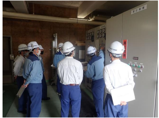
■ 予備発電機への切替え訓練
