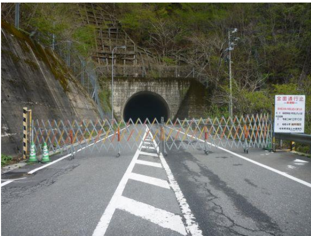
■ 通行止めの様子
