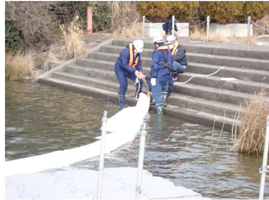
■ フェンス設置の様子
