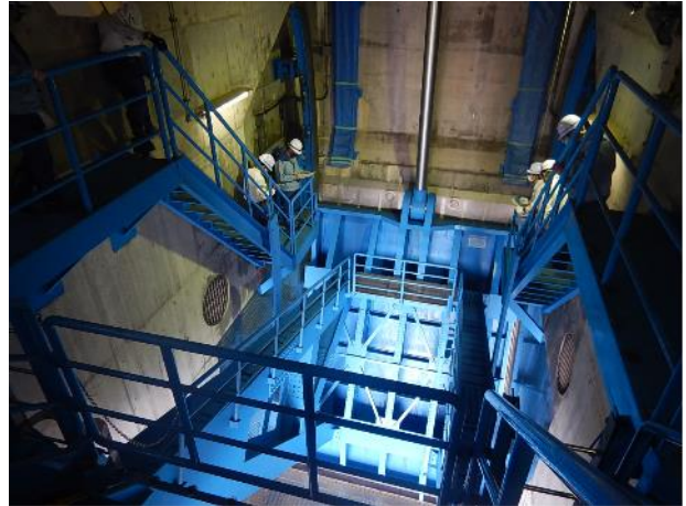
■ 洪水吐きゲート放流前点検訓練
