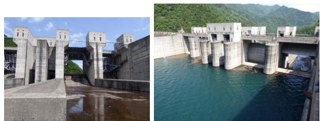
■ 洪水吐きゲートの全開の様子
