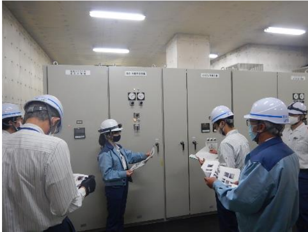
■ 予備発電機起動操作訓練
