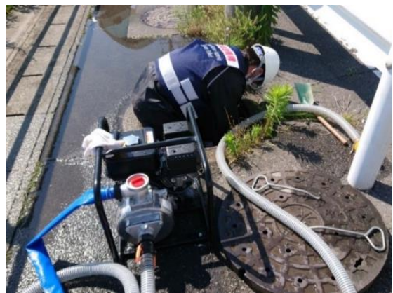
■ 空気弁の漏水対応
