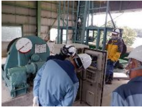
■インクライン操作盤の確認
