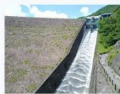
岩屋ダム(放流設備)
