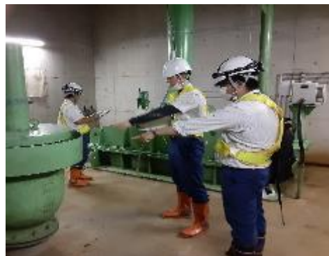
■ 加佐登調整池での設備点検状況
