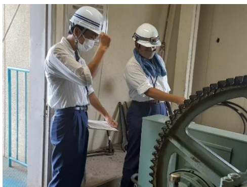
■木曾川大堰ゲート設備の点検
