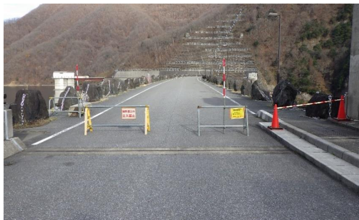
■冬は事故防止のため通行止めになっている堤体上道路
