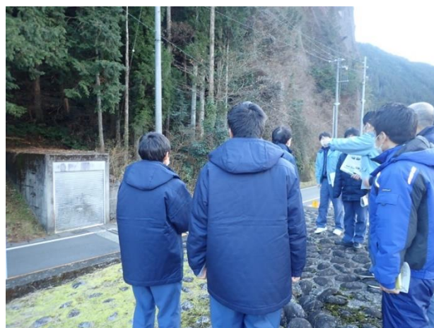
■豪雨時に閉鎖される陸閘の位置を確認
