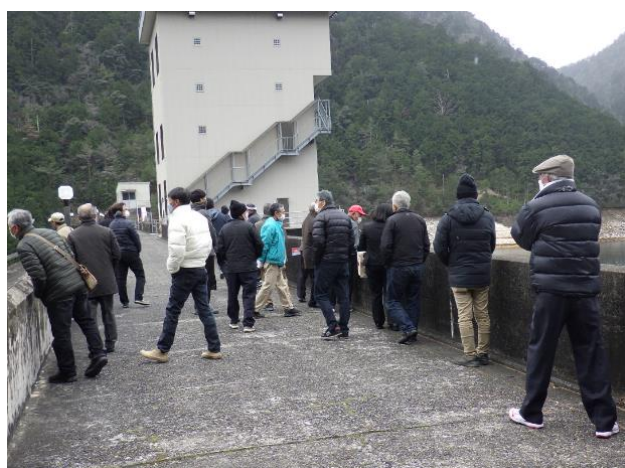
■宇連ダム堤体
