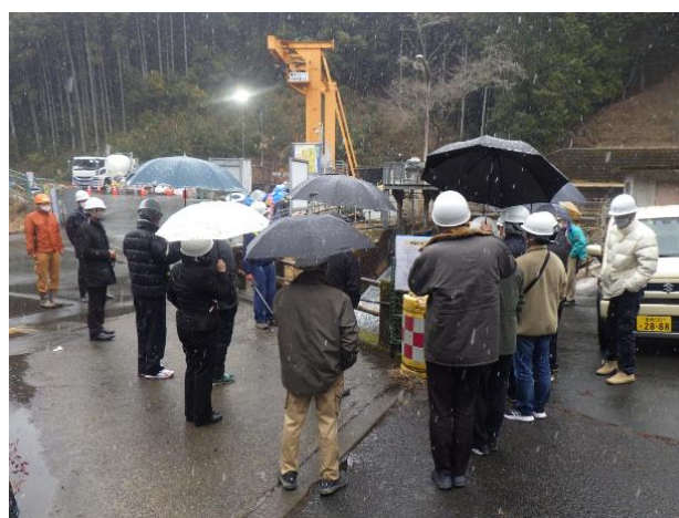
■東西分水工、大野導水併設水路工事 工事現場
