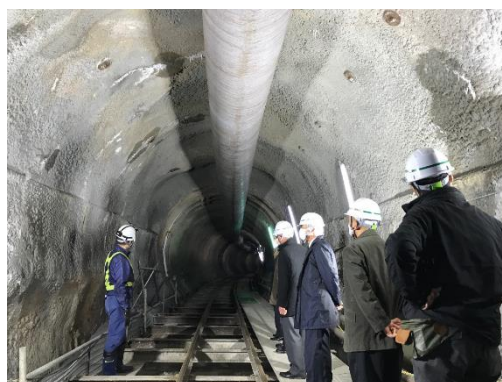
■大野導水併設水路工事坑内の説明
