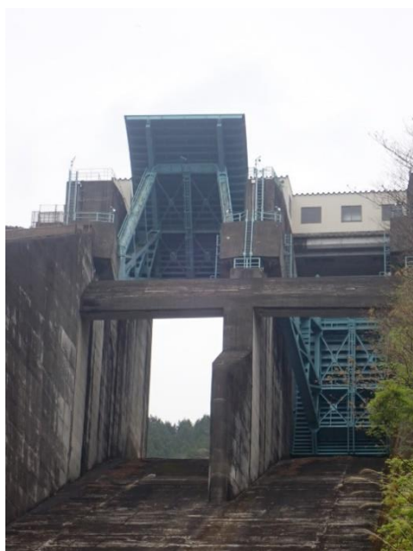
■点検中のラジアルゲート（正面）
