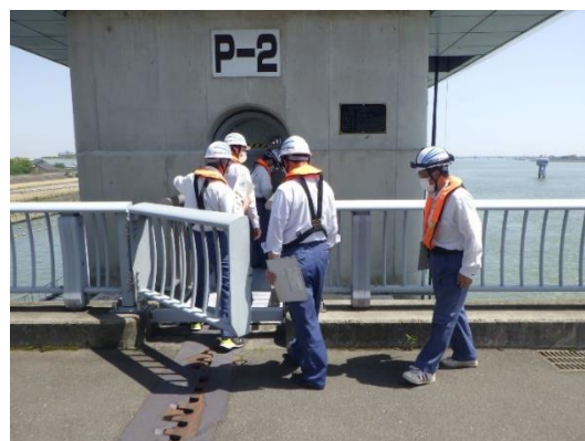
■堰設備点検の様子
