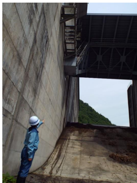
■ゲート点検の様子
