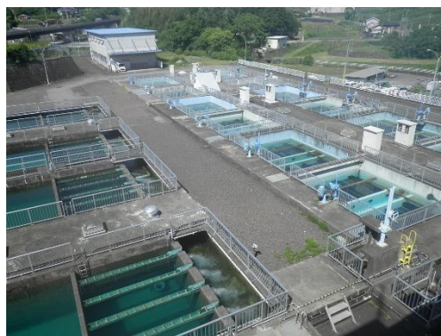
■浄水場内 施設全景
