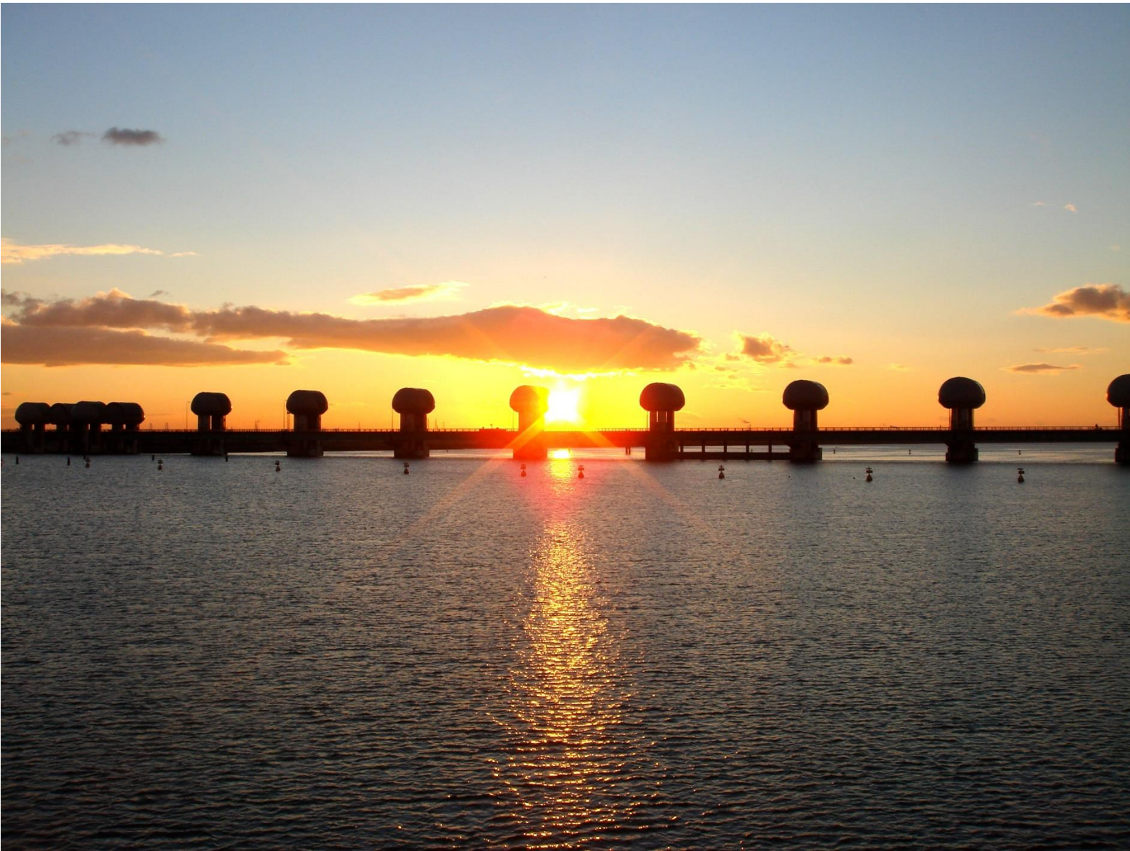
長良川河口堰(三重県桑名市)
