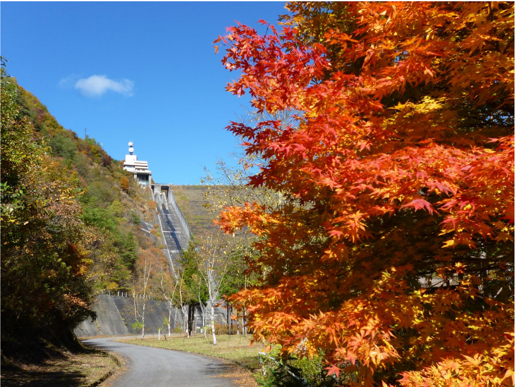
味噌川ダム(長野県木祖村)
