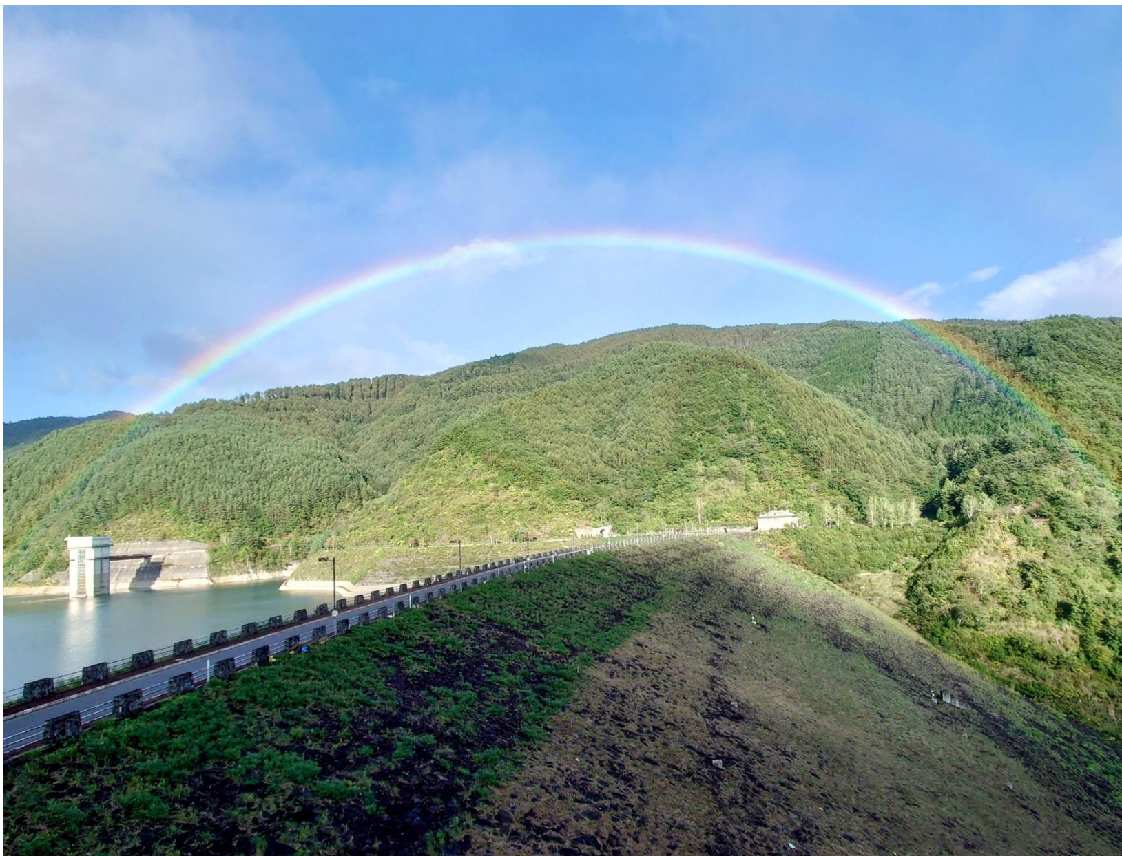
味噌川ダム(長野県木祖村)
