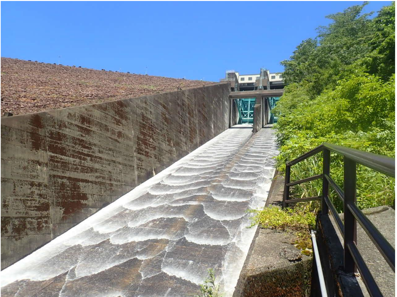
岩屋ダム(岐阜県下呂市)
