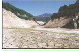
枯渇した岩屋ダム(平成6年8月)
