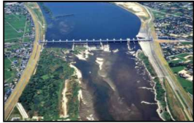
平成6年渇水時には、木曽川大堰からの放流量がほぼ0m³/sまで減少し、シジミの斃死等が発生
