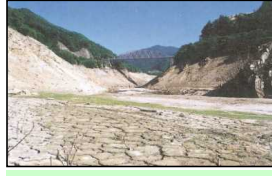
枯渇した岩屋ダム(平成6年8月)
