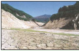
枯渇した岩屋ダム(平成6年8月)
