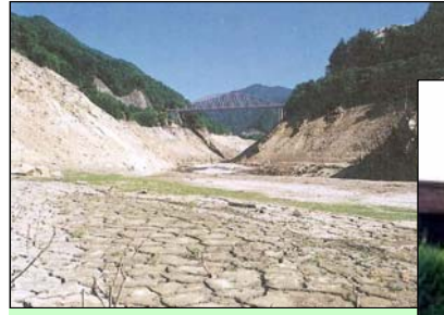
枯渇した岩屋ダム(平成6年8月)
