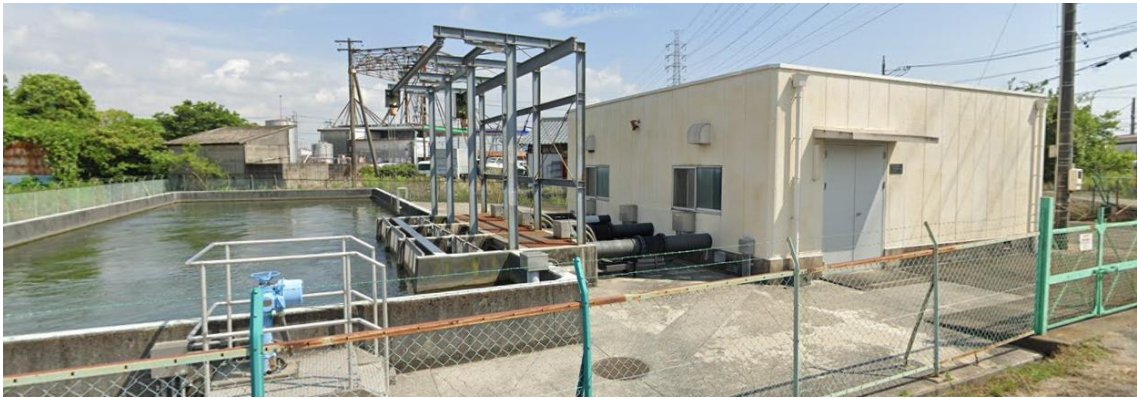
揚水機場（建屋、屋内弁類・集合管）参考写真
