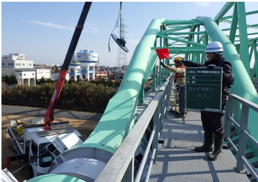
木曾川左岸堤防道路からの 資材搬入状況例
