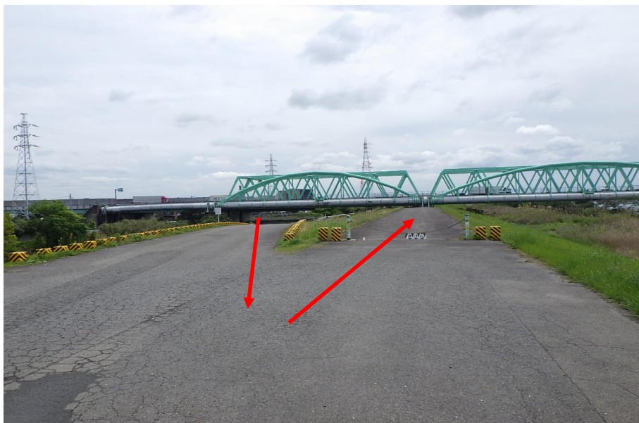
木曾川左岸堤防道路への進入口
