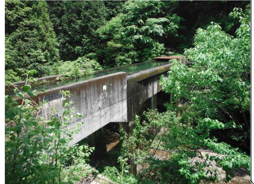
小牧谷水路橋
