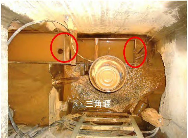
②三角堰(2箇所)
