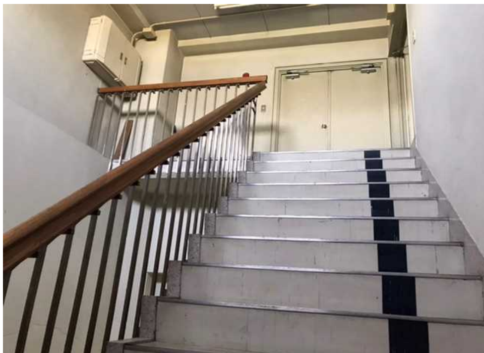
建物内から屋上への出口
