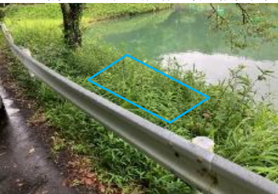
上飯田調整池右岸 測定器収納盤設置位置(ガードレールより池側)
