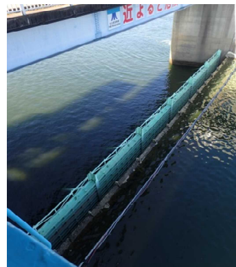
仮設ゲート設置状況
