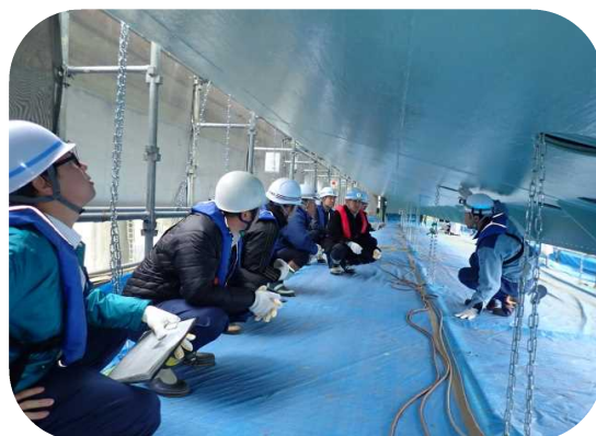
ゲート扉体の状態確認
