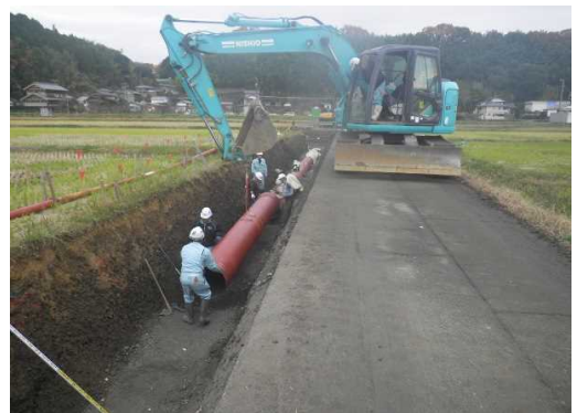
米田用水路下米田信友工区改築工事
