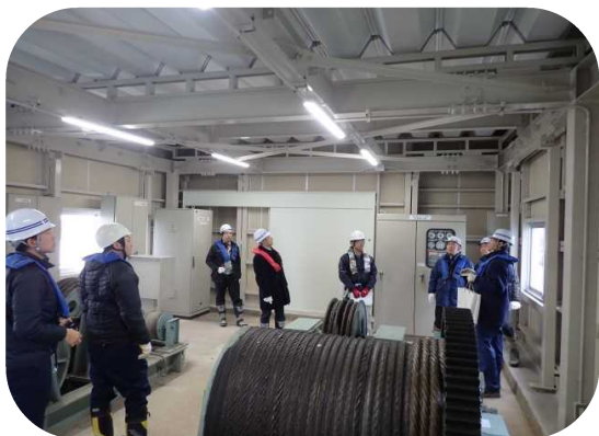
建屋内での説明状況
