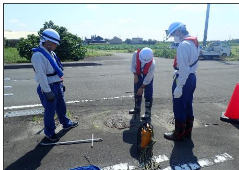
海部幹線水路:空気弁点検
