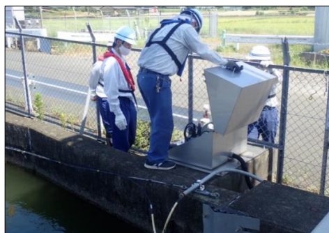
海部幹線水路:水位計点検
