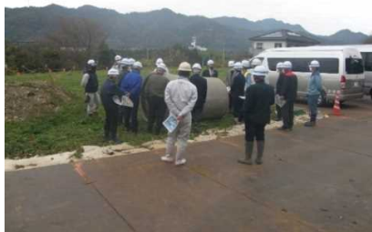
既設PC管の劣化状況
