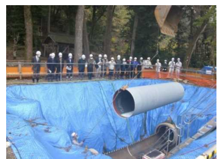
挿入管(鋼管)施工状況
