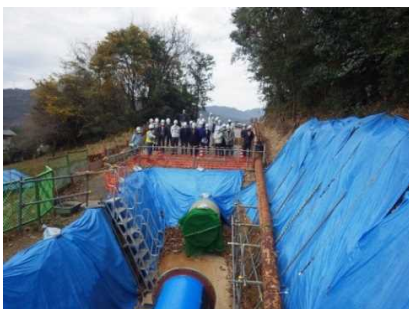
仮廻し管接続状況 (工事終点部)
