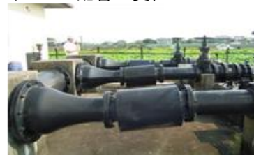
ポンプの配管の変位
