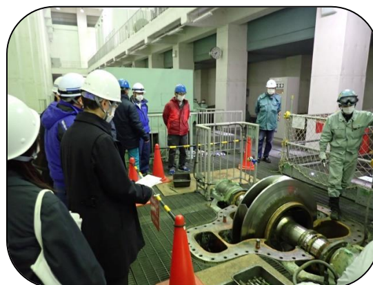
ポンプ設備の整備状況確認
