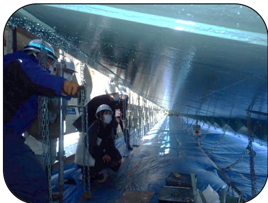
ゲート扉体の状態確認
