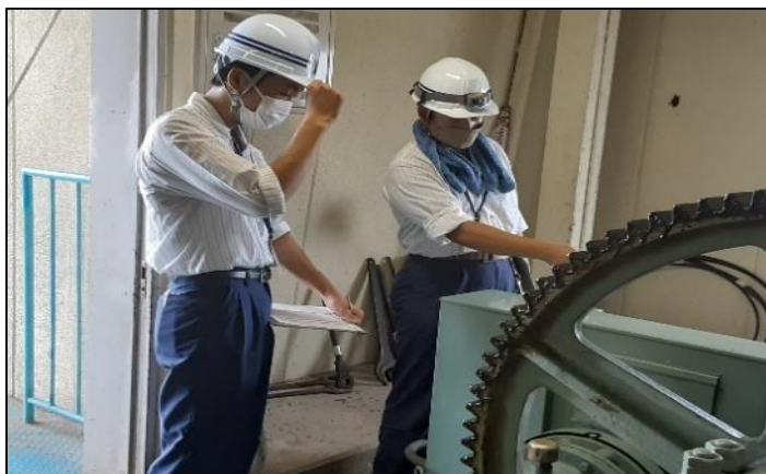
木曾川大堰ゲート設備の点検
