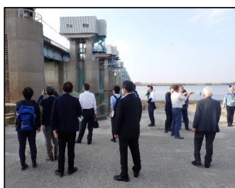
臨床技術小委員会 木曾川大堰視察
