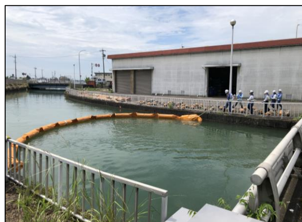
オイルフェンス設置状況
