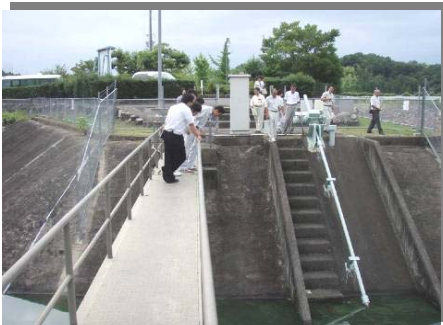
調整池見学の様子（施設）
