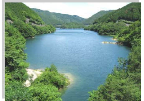
岩屋ダム(満水)
