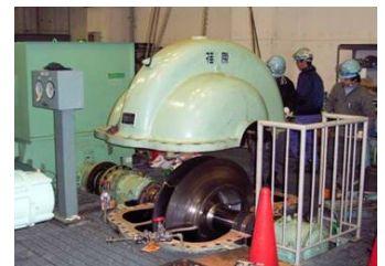
上部ケーシング組み込み状況
